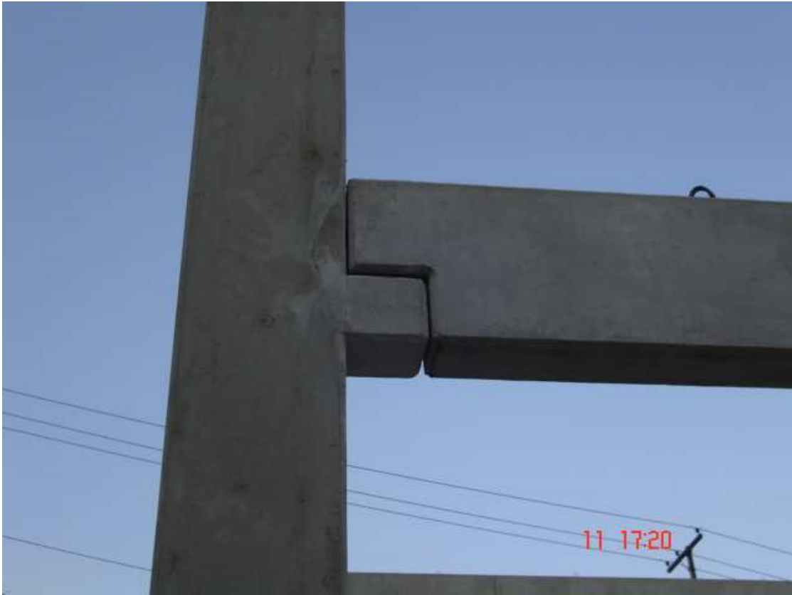
Figura 5.1 Viga armada retangular com dente de Gerber.
