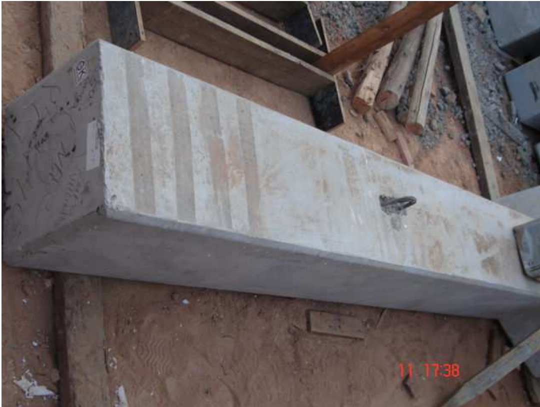
Figura 3.2.4 – Dispositivo auxiliar tipo laço chumbado.
