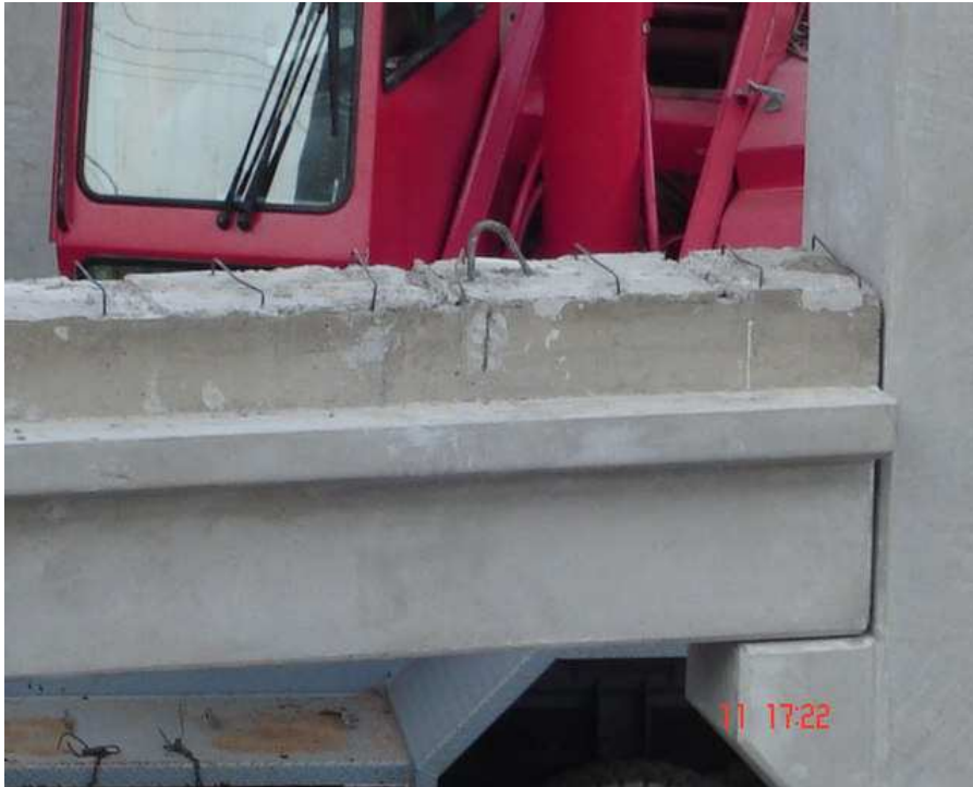
Figura 5.4 – Viga-suporte com estribos a espera da segunda concretagem.
