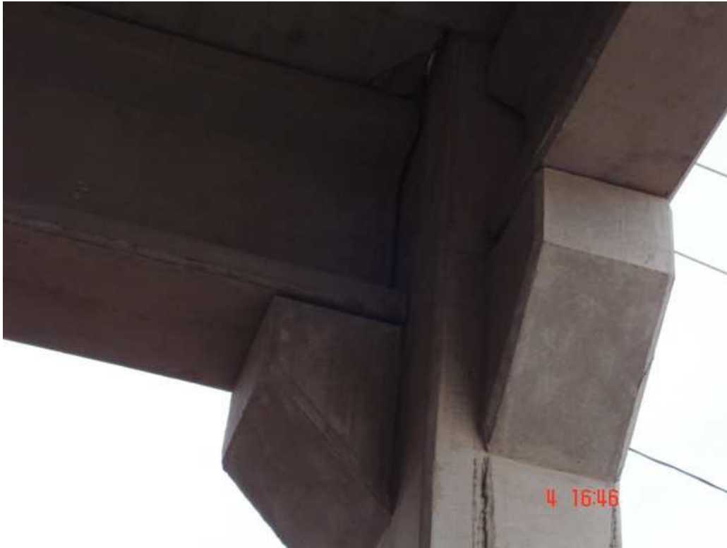
Figura 5.2 – Vigas pré-moldadas em formato “I”.
