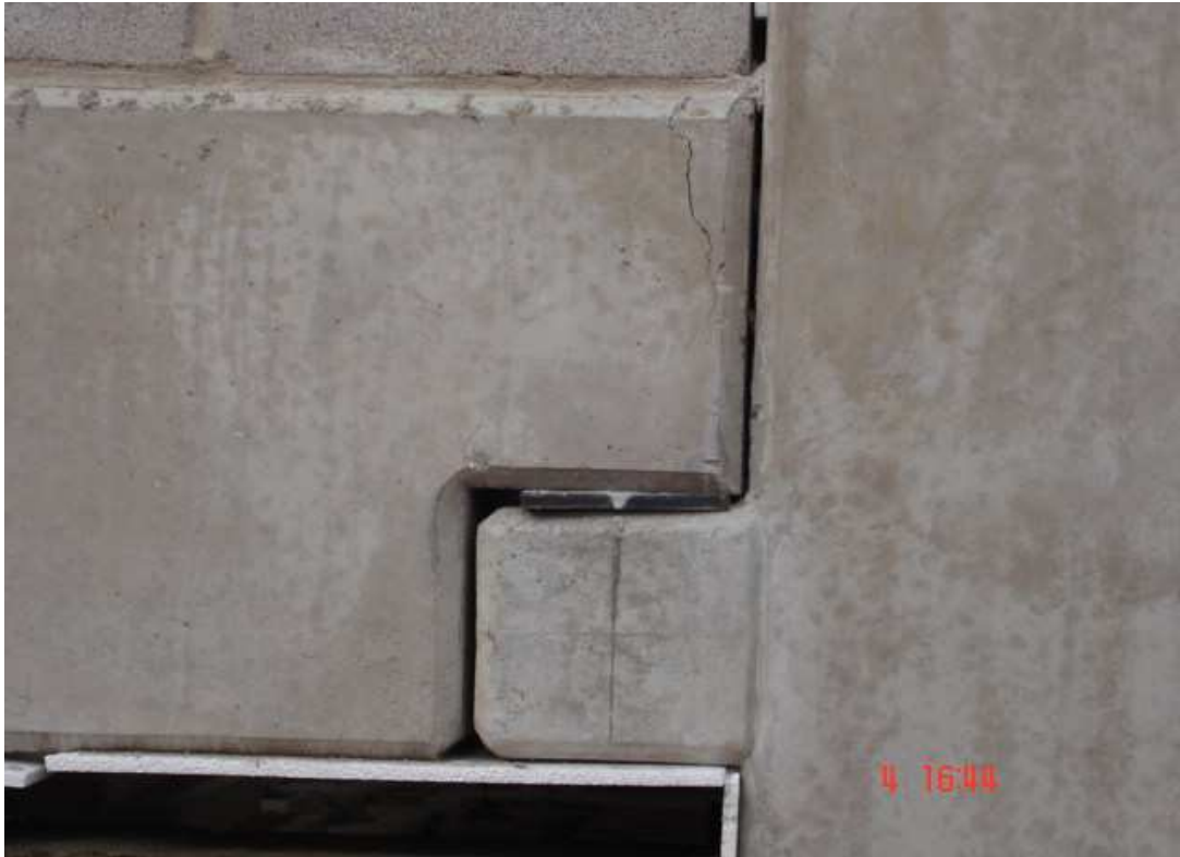
Figura 4.4.2 Dente de Gerber, viga e console retangulares.
