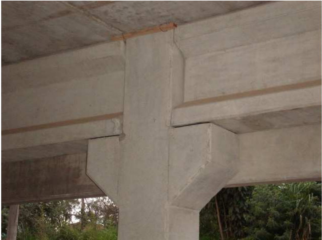
Figura 4.4.1 Vigas tipo I apoiadas em consoles trapezoidais.
