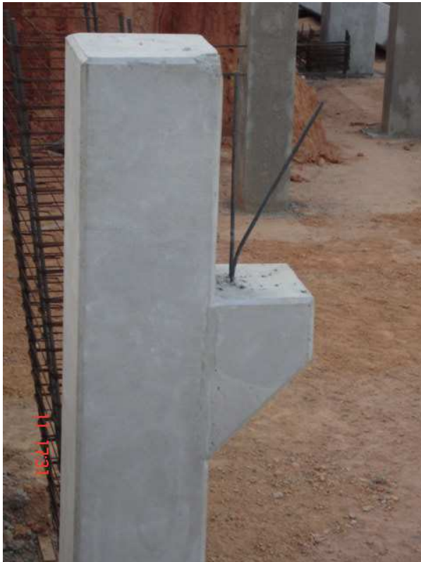
Figura 6.1.7 – Chumbadores fixados no console do pilar, aguardando fixação da viga.
