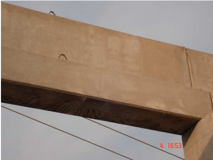
Figura 5.3 – Exemplo de viga-calha em formato “J”.
