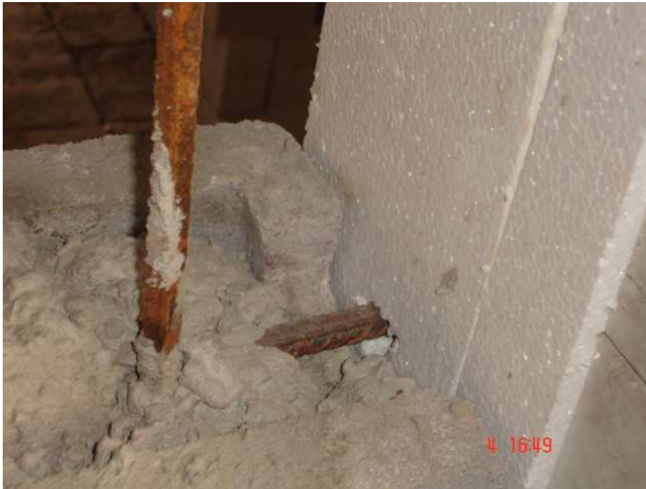
Figura 4.2.1 Detalhe de amarração de alvenaria no pilar.
