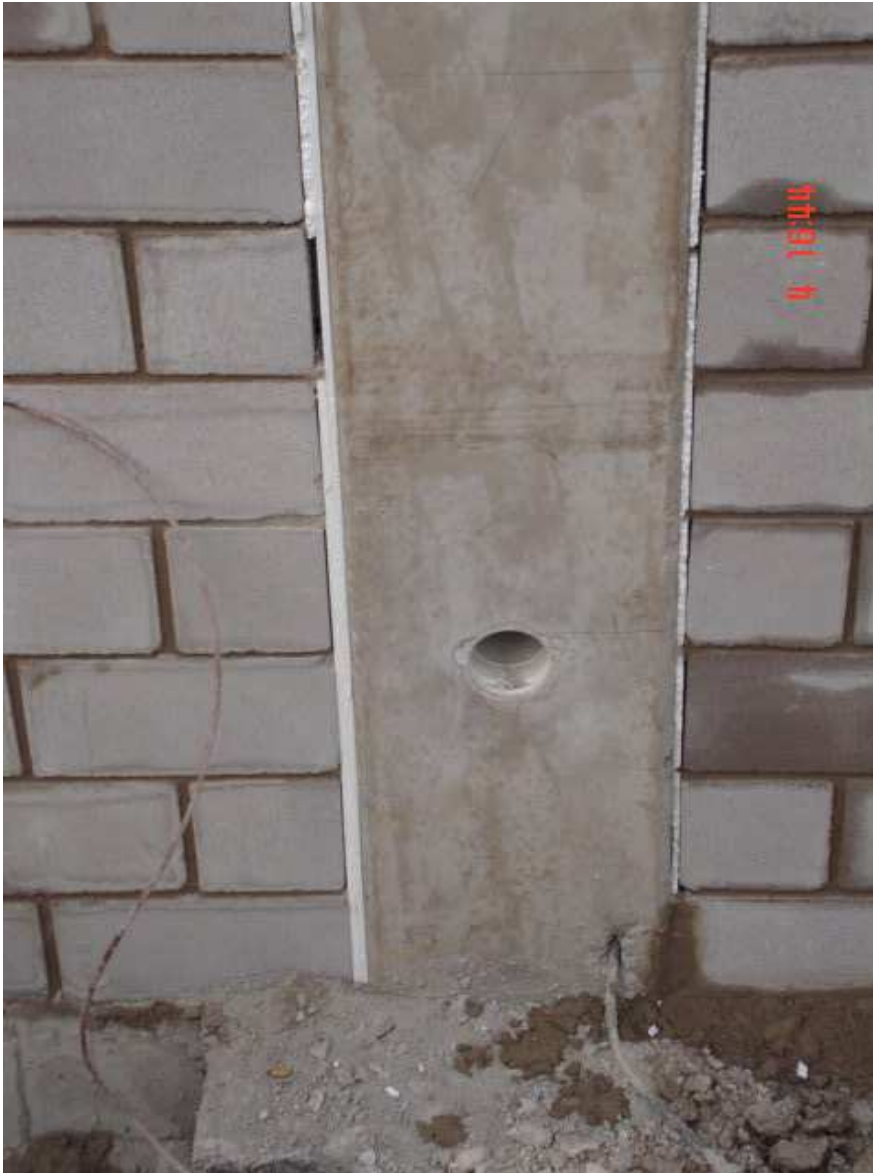
Figura 4.3.1 Pilar com tubulação de \phi 100 mm para o escoamento das águas pluviais.
