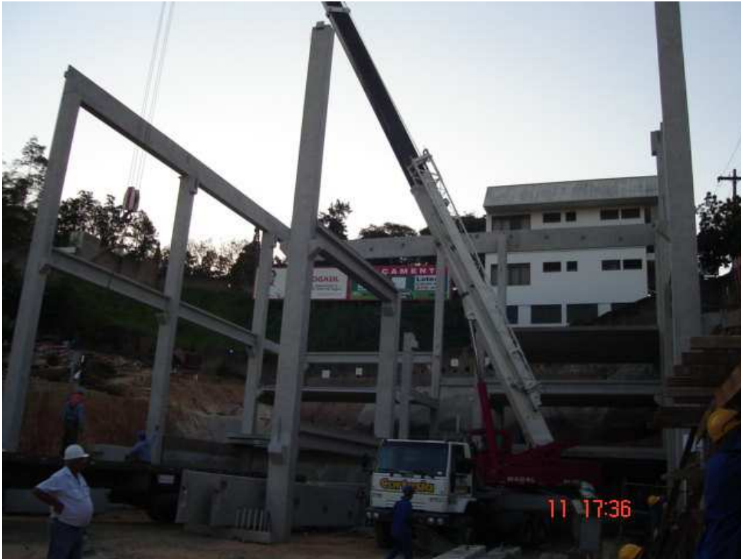
Figura 3.2.5- Elementos pré-moldados sendo içados pelo guindaste acoplado ao caminhão.
