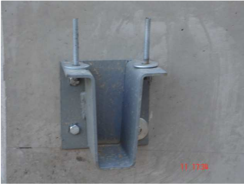
Figura 5.5- Detalhe do suporte de apoio inferior.
