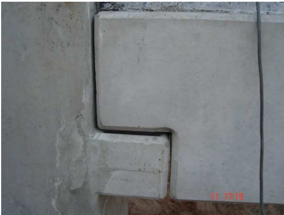
Figura 1.2 – Ligação articulada entre pilar e viga pré-moldados.
