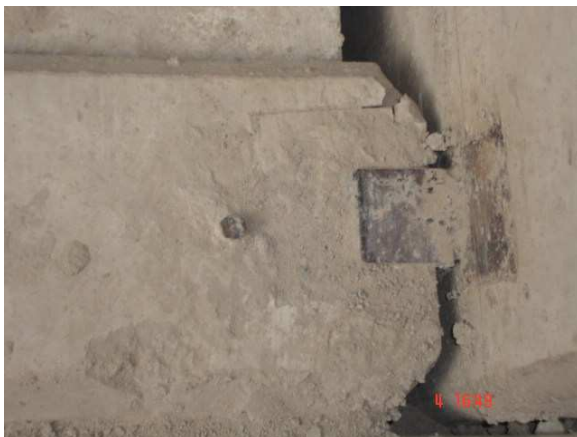
Figura 6.1.6 – Ligação viga-pilar com solda metálica.
