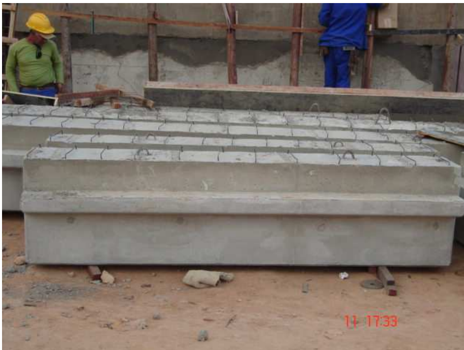
Figura 5.8 – Foto das peças preparadas para estocagem das vigas pré-moldadas no canteiro de obras e detalhes das alças para içamento.
