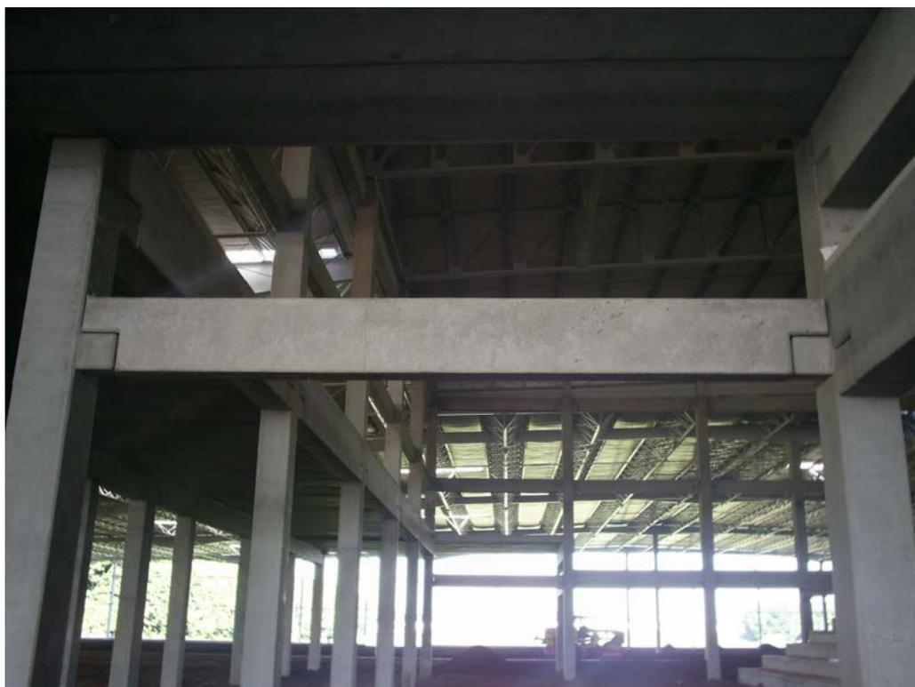
Figura 4.4.3 – Console com dente de Gerber.
