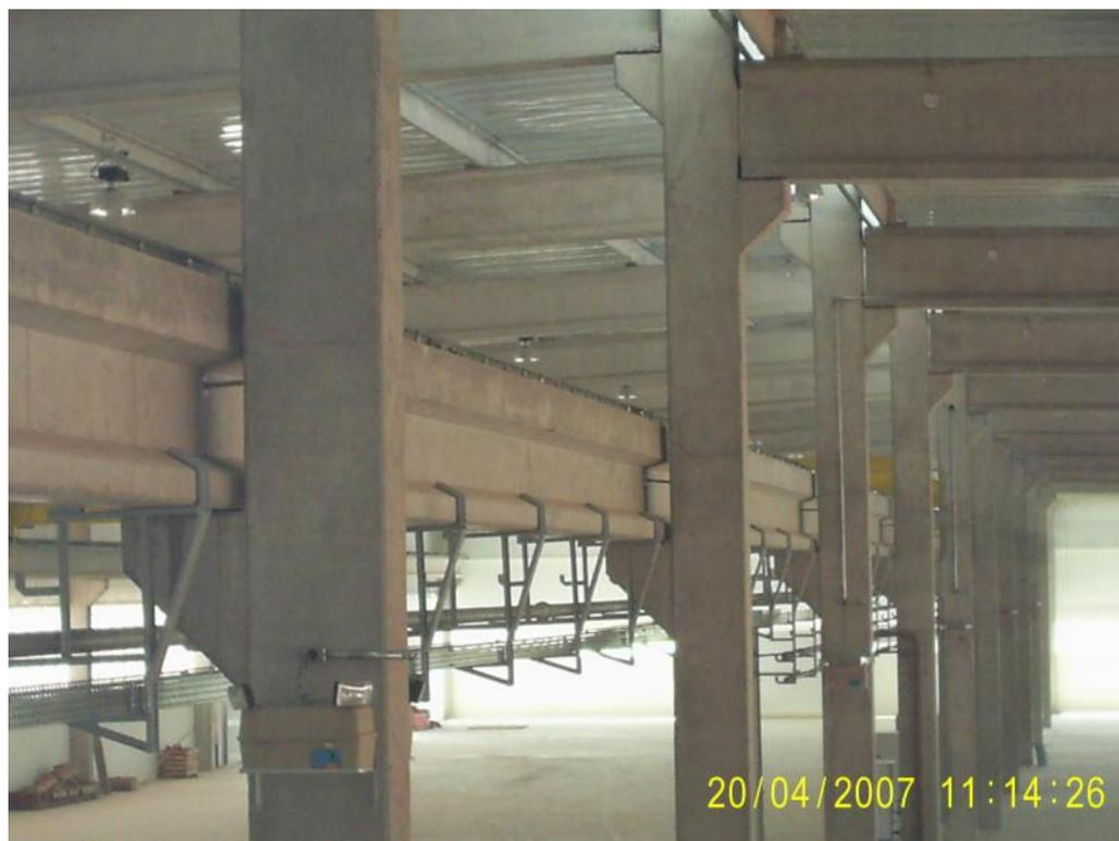
Figura 5.4.1 – No detalhe a viga de rolamento.
