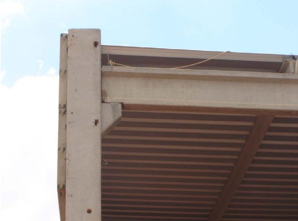
Figura 4.4.1 – Console simples para viga I.
