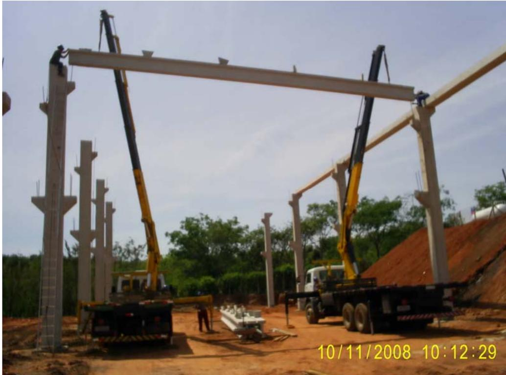
Figura 6.1.1 – Lançamento das vigas de coberturas com auxílio de caminhão munck.
