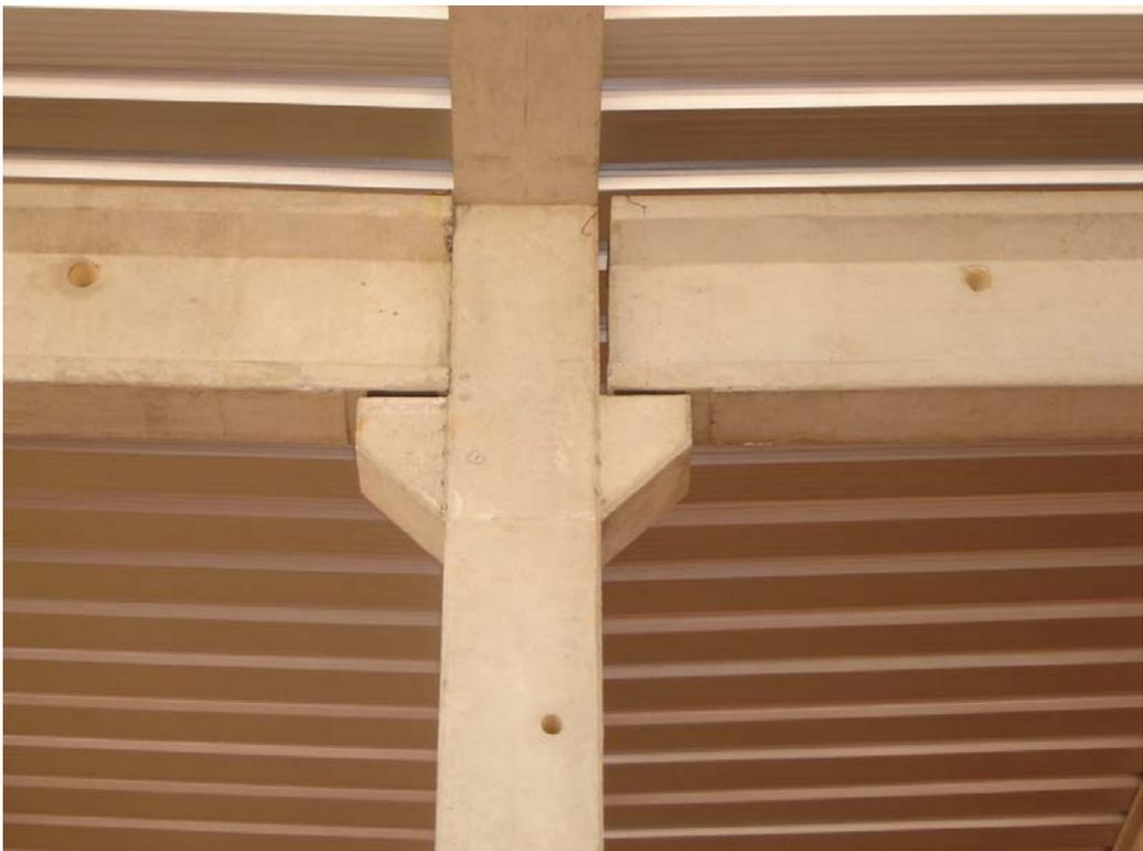
Figura 4.4.2 – Console duplo para viga I.
