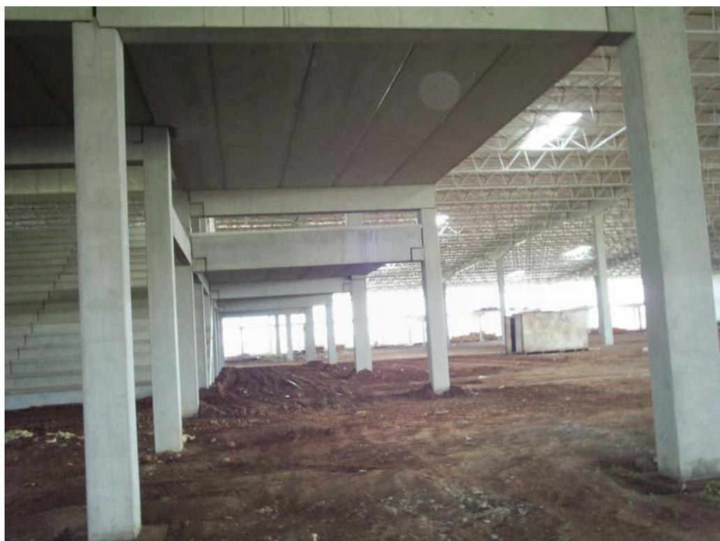
Figura 5.2.1 – Ao fundo a viga retangular com dente de Gerber.
