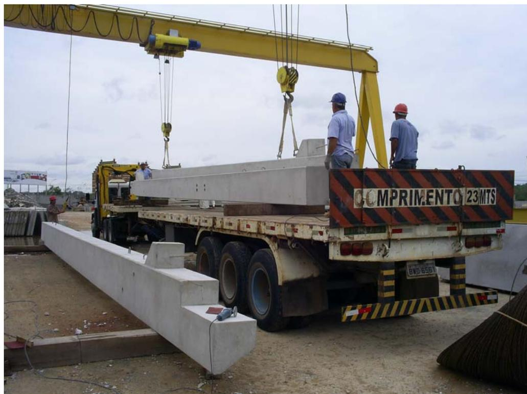
Figura 3.3 – Carreta especial transportando coluna com 16,70m de comprimento.
