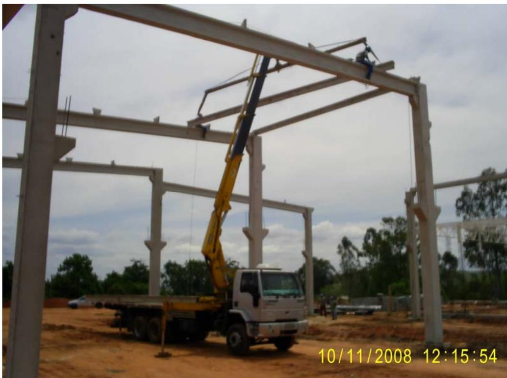
Figura 6.1.2 – Lançamento das vigas terça com auxílio de caminhão munck.
