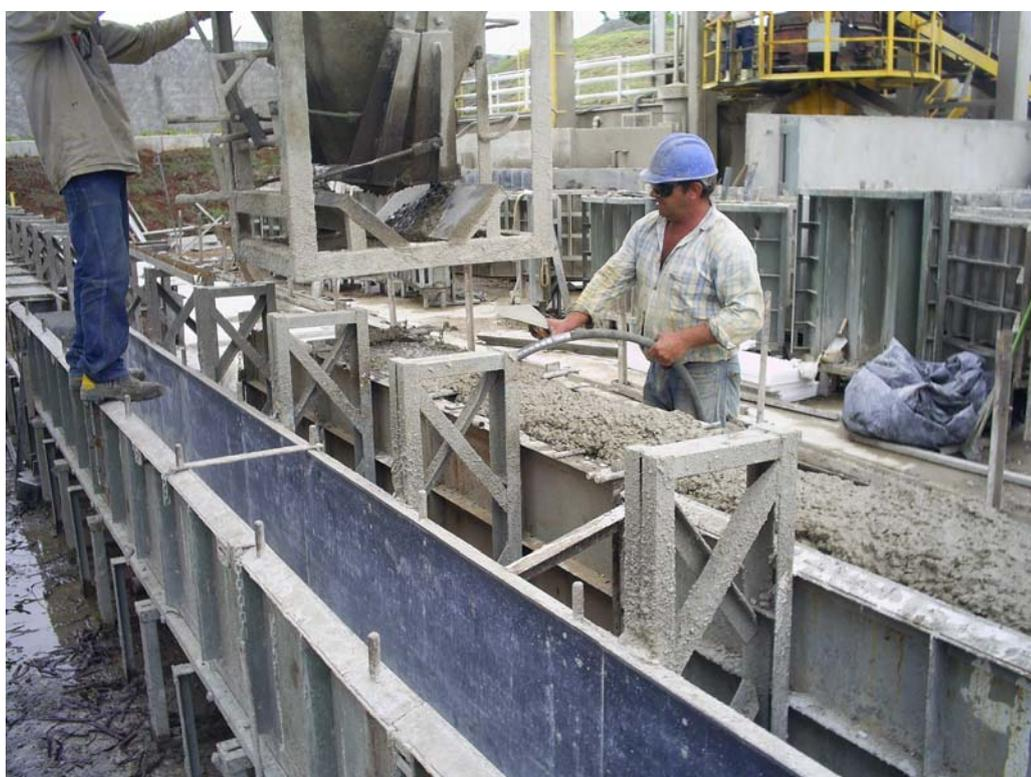
Figura 2.1.6 – Lançamento e adensamento do concreto.
