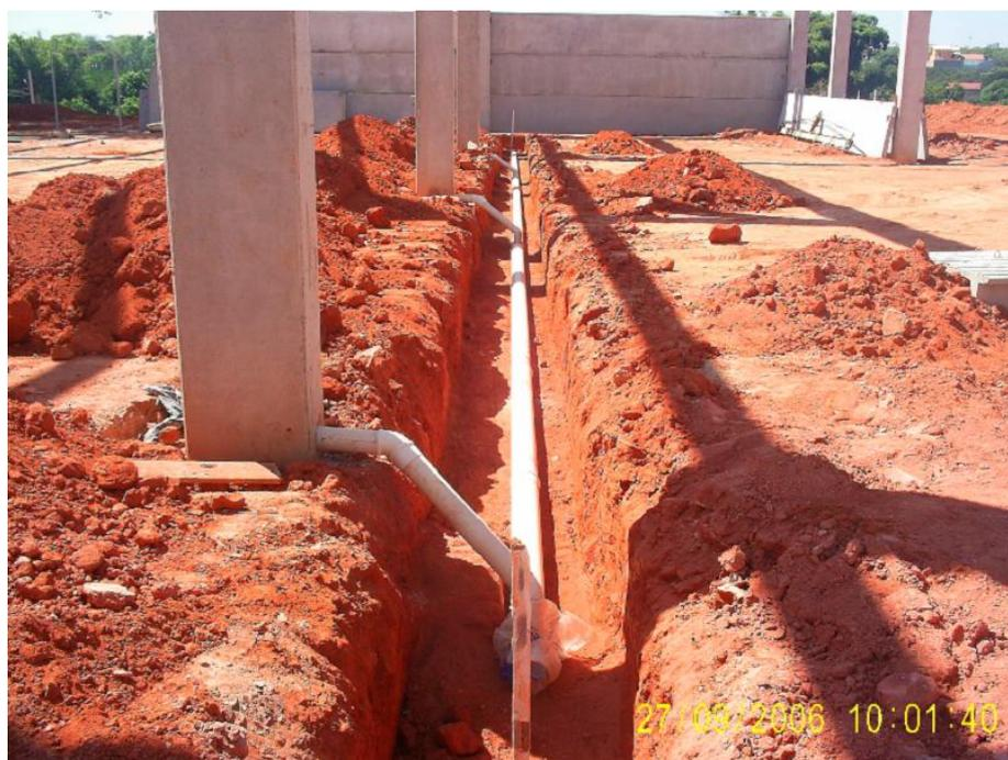
Figura 4.1 – Detalhe de ligação do tubo de espera do pilar com a rede pluvial.
