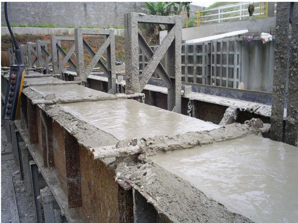
Figura 2.5.1 – Em destaque os elementos de ancoragem da fôrma.
