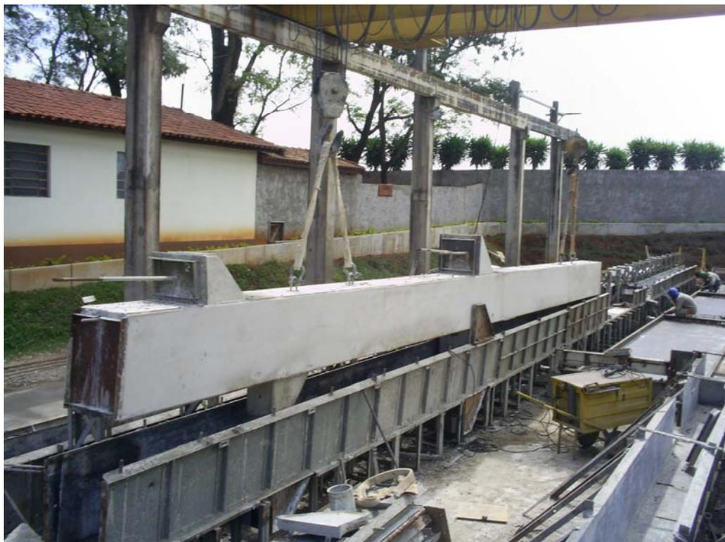
Figura 2.1.7 – Desmoldagem do elemento.
