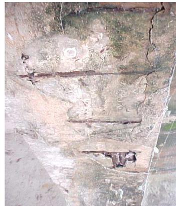
**Foto 2** – Armadura exposta em área de concreto desagregado, na face inferior da viga lateral direita, junto ao apoio 2
