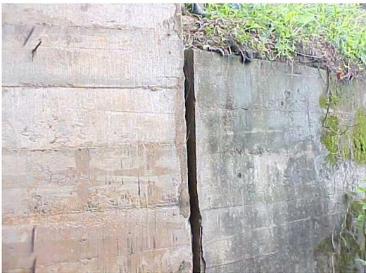
**Foto 9** – Detalhe da abertura existente entre o pilar e o muro de contenção, lado de Pinhal, lado direito
