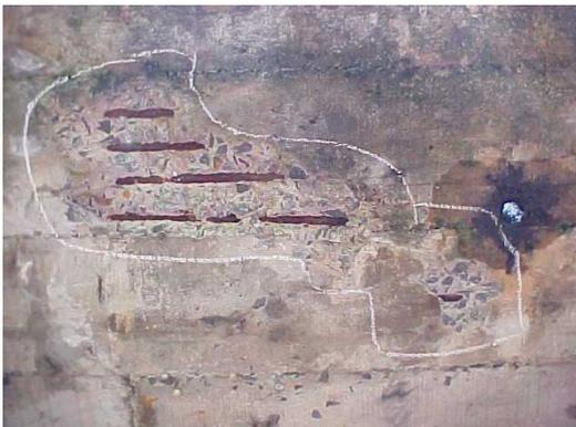
**Foto 3** – Detalhe de armadura exposta e concreto deslocado na face inferior da laje do lado direito, próximo ao apoio 2
