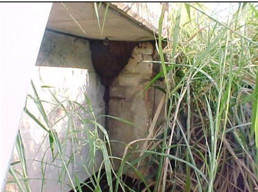
**Foto 11** – Armadura exposta e concreto destacado na cortina e ala de contenção no encontro de SP, lado esquerdo
