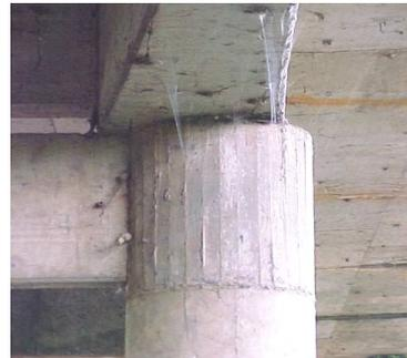
**FOTO 8** – Vista da travessa do apoio AP3 apresentando desalinhamento do eixo das vigas em relação ao eixo dos pilares.
