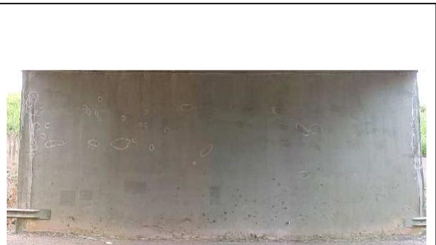
**FOTO 2** – Montagem fotográfica de uma vista inferior da obra, mostrando as anomalias cadastradas no pilar parede do encontro E1.
