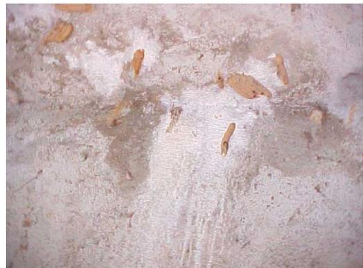
**Foto 7** – Área com manchas de carbonatação do concreto e umidades, junto a mísula da viga esquerda entre as transversinas centrais.
