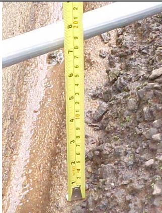
**Foto 1** – Detalhe da medida do pavimento apresentando aproximadamente 18 centímetros de espessura
