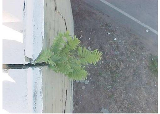
**FOTO 4** – Vista superior da junta da ala com a presença de vegetação.
