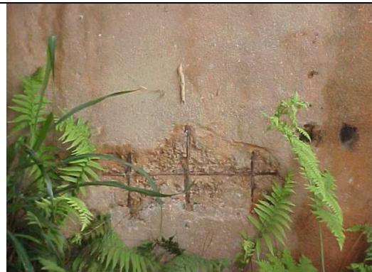
**Foto 6** – Área de concreto desagregado na ala lateral direita da cortina C1
