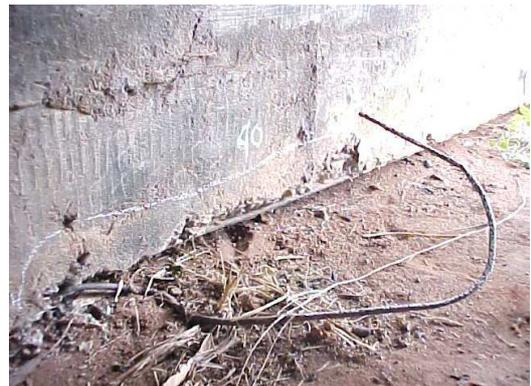
**Foto 4** – Área de armadura exposta e concreto segregado na face inferior da cortina C2 do lado Pinhal
