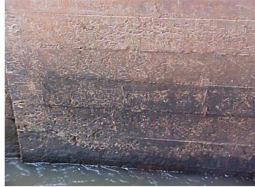
**Foto 8** – Detalhe do pé do pilar junto ao nível d'água com desgaste
