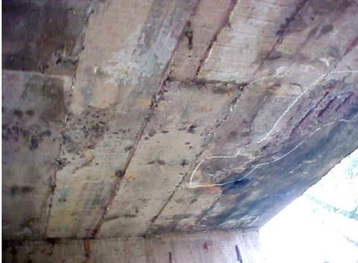
**Foto 1** – Vista inferior da laje com áreas de concreto desagregado e armadura exposta
