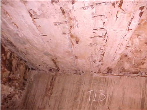
**Foto 7** – Laje superior onde se encontram áreas com armadura exposta e concreto desagregado devido a insuficiência de cobrimento. (Dentro do caixão perdido inteiro c/ armadura exposta)
