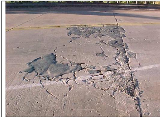
**Foto 1** – Pavimento de concreto simples danificado sobre o tabuleiro já preenchido com massa asfáltica anteriormente.
