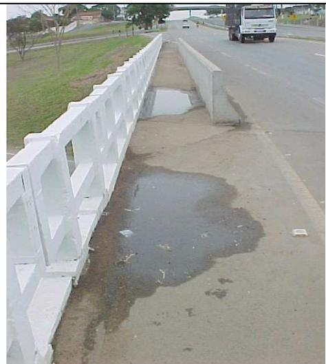
**FOTO 2** – Vista do passeio do lado da divisa de Minas. Nota-se o acúmulo de água sobre a obra (acima) e junto a ala do encontro.
