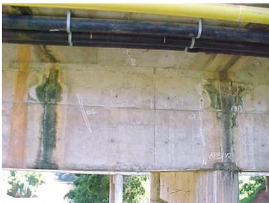
**FOTO 7** – Áreas com a superfície da viga lixiviadas devido ao escoamento das águas pelos buzinetes
