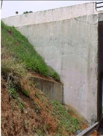
**FOTO 5** – Montagem fotográfica mostrando os detalhes das anomalias cadastradas na ala do encontro E2, lado de Águas da Prata.
