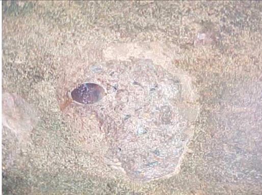
**Foto 8**– Área de concreto segregado na face inferior da laje em balanço sob o passeio causado por falta de extensores no tubo de drenagem.
