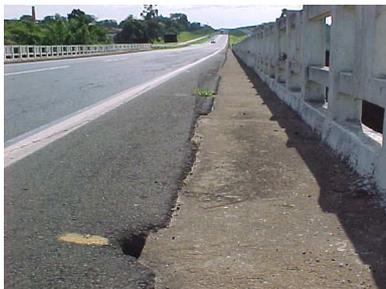
**FOTO 1** – Detalhe da camada de pavimento de concreto asfáltico com aproximadamente 4 cm sobre o passeio junto ao refúgio ao longo da obra, somando cerca de 19 cm de espessura de concreto asfáltico.
