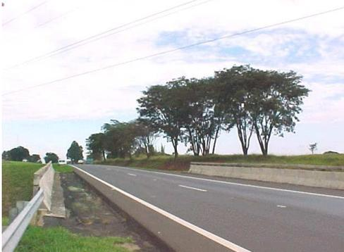
**FOTO 1** – Detalhe do degrau do pavimento existente com 17cm de espessura, no lado esquerdos, sentidos Campinas.
