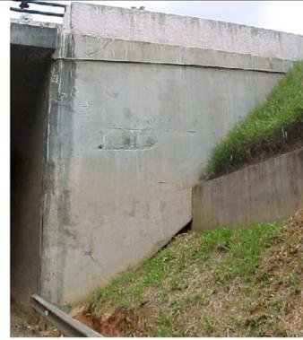
**FOTO 4** – Montagem mostrando os detalhes das anomalias cadastradas na ala do encontro E1, lado de Águas da Prata
