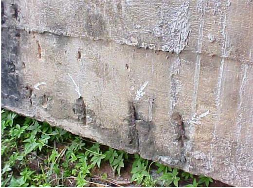
**Foto 7** – Detalhe de armadura exposta na parte inferior da cortina do lado Mogi Guaçu
