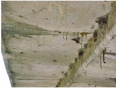
**FOTO 3** – Trincas transversais com sinais de carbonatação do concreto e formação de estalactite em pontos isolados ao longo do passeio.
