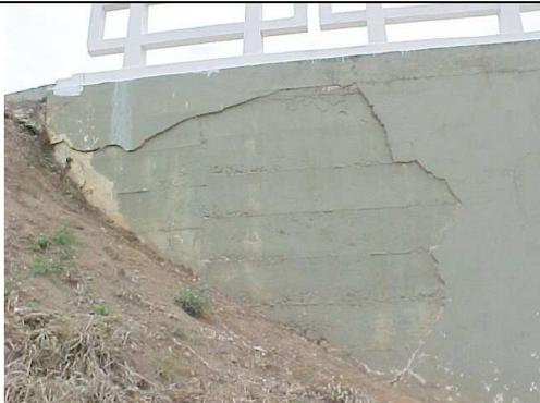
**FOTO 5** – Detalhe do deslocamento do revestimento.
