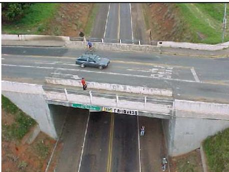
**FOTO 1** – Vista superior da obra, face do lado de Águas da Prata, mostrando as três faixas de rolamento e os passeios laterais protegidos por defensas rígidas do lado interno e por gradil do lado externo
