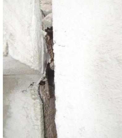
**FOTO 2** – Detalhe de concreto segregado e armaduras expostas na junta do muro com a ala do canteiro.
