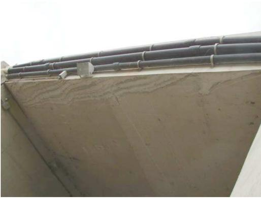
**FOTO 1** – Vista da laje. Nota-se as marcas de escorrimento d'água devido à ausência de pingadeira.
