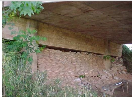
**Foto 12** – Vista do apoio 4 com os sacos instalados para contenção do aterro de encontro, lado MG.
