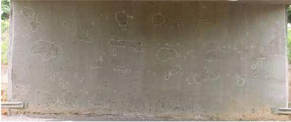
**FOTO 3** – Montagem fotográfica de uma vista inferior da obra, mostrando as anomalias cadastradas no pilar parede do encontro E2
