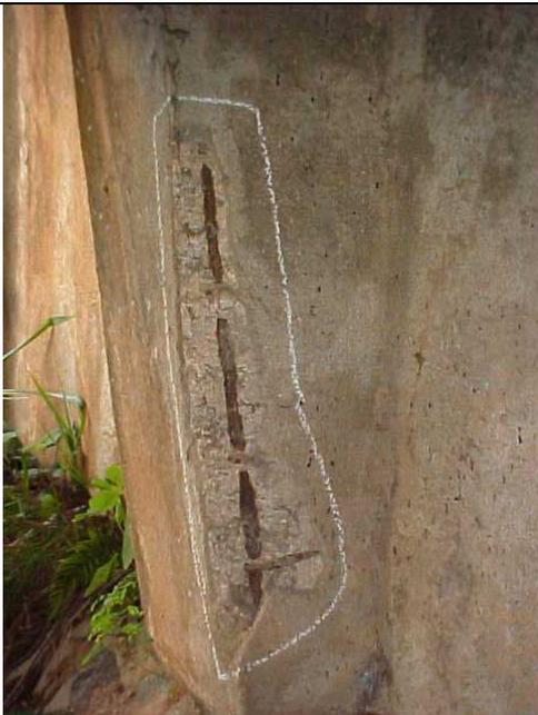
**Foto 3** – Detalhe da extremidade da viga lado esquerdo, junto a cortina C2, apresentando armadura exposta e concreto desagregado
