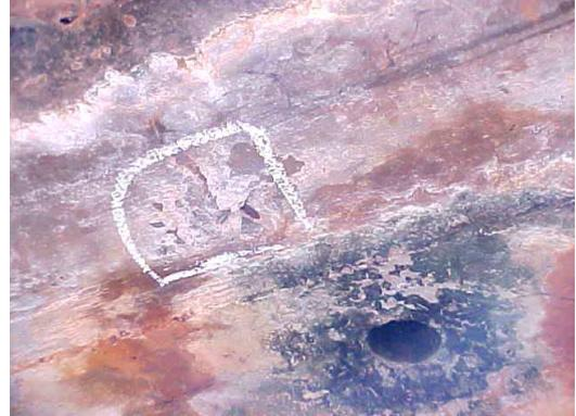
**Foto 2** – Detalhe de vista inferior da laje em área de concreto desagregado junto a ponto de drenagem sem pingadeira
