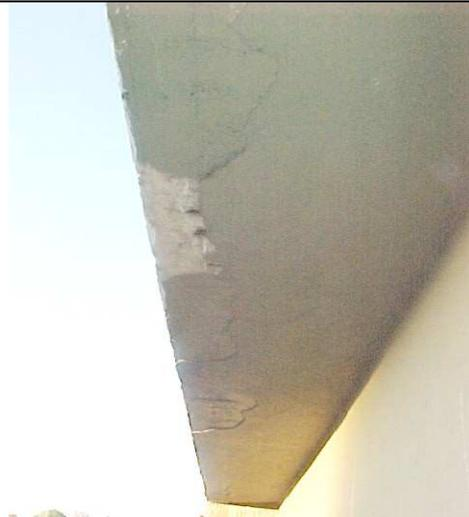
**FOTO 4** – Deslocamento do revestimento e concreto segregado no balanço
