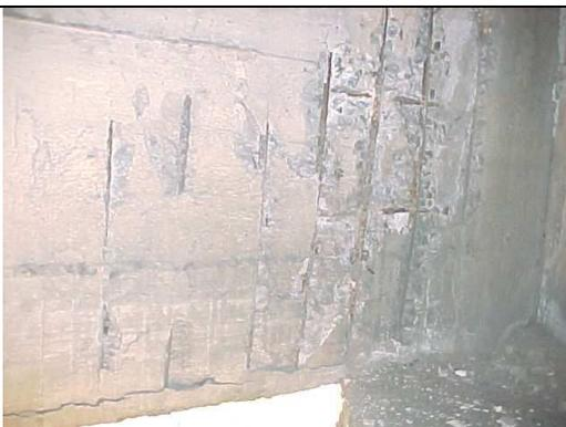
**FOTO 7** – Concreto segregado e armaduras expostas na viga 1 face leste.
