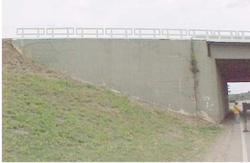
**FOTO 3** – Vista da ala do encontro do lado de Mogi-Guaçu. Não há drenagem na cabeceira. Existem trechos com o revestimento deslocado e a presença de vegetação na junta da ala.
