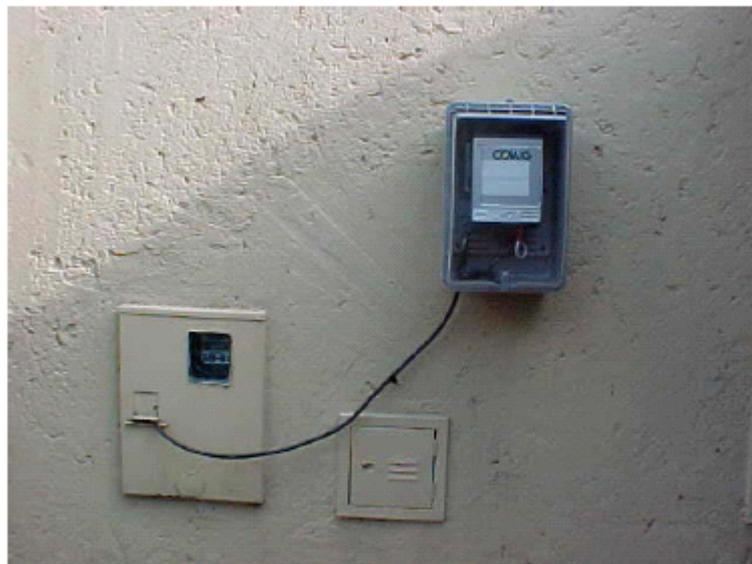
Figura 4. Repetidor colocado próximo ao medidor
