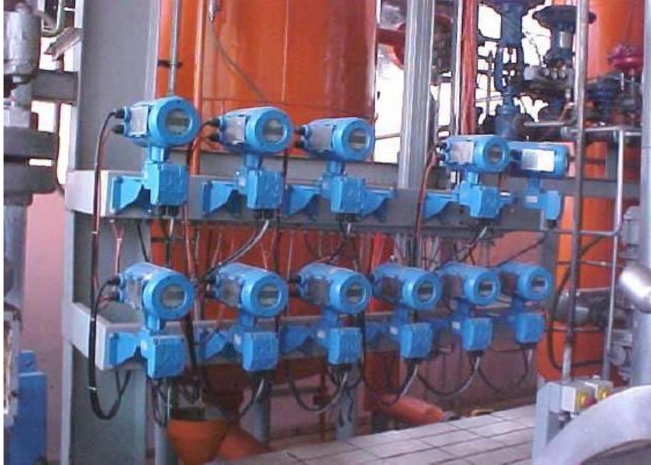
Figura 3.4: Instrumentos Profibus-PA no campo [ Cocamar ]
