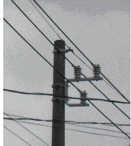
Figura 18: Braço suporte tipo “C” instalado
