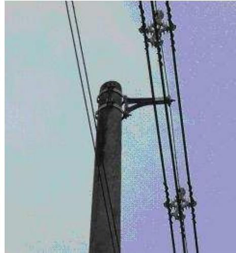
Figura 16: Braço suporte tipo “L” instalado
