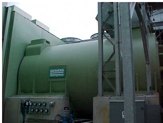
Figura 16 – Gerador a gás da usina de Uruguaiana, 187 MW (AES)
