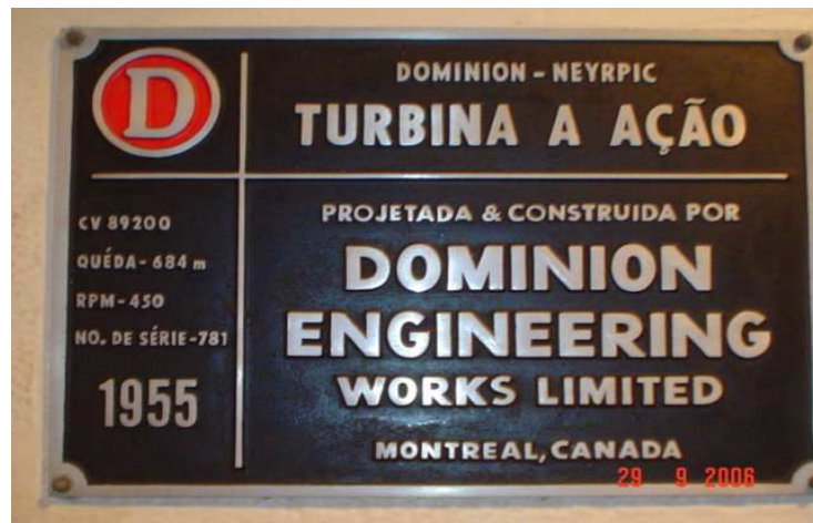
Figura 11 – Dados da placa da turbina Kaplan (Usina Henry Borden), 2 x 72 MW (EMA/E)
