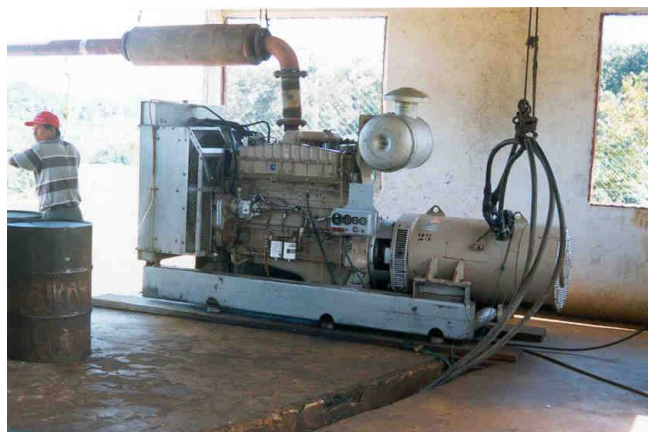
Figura 17 – Gerador acionado através de um motor diesel, em Lourenço, no Amapá (CEA)
