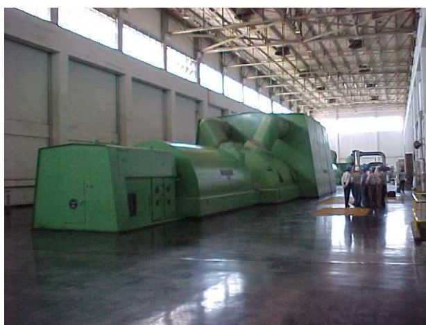
Figura 15 – Geradores da usina termelétrica de Santa Cruz, 2 x 81,6 e 2 x 217,6 MW, óleo combustível e gás natural (Furnas)
