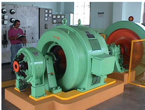
Figura 13 – Gerador da PCH da Usina Americana, 2 x 904 kW (CPFL)
