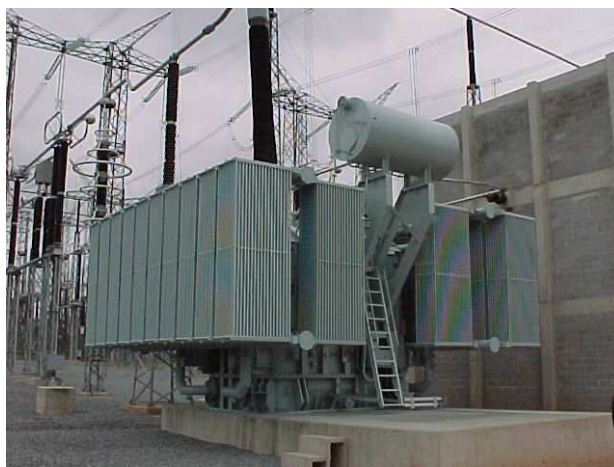
Figura 24 – Reator em derivação de Tijuco Preto 750 kV, 110 MVar (Furnas)
