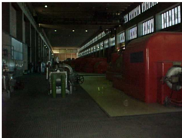
Figura 14 – Geradores da usina termelétrica de Presidente Médici, 2 x 63 e 2 x 160 MW, carvão mineral (CEEE)
