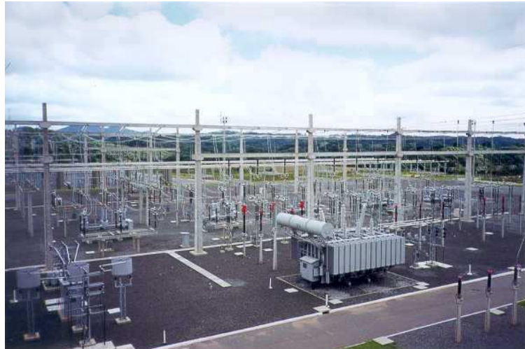
Figura 08 – Subestação de Bateias 500 kV (Copel)
