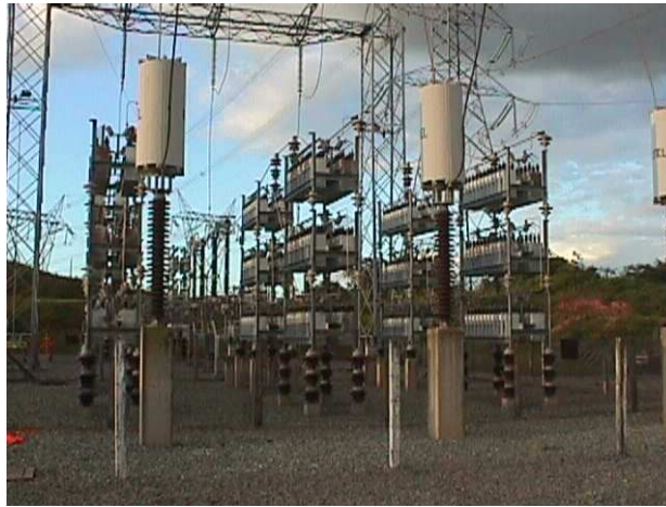
Figura 23 – Banco de capacitores em derivação de São Luís II 230 kV (Eletronorte)
