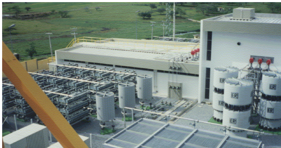
Figura 27 – Compensador estático de Campina Grande 230 kV, 0/+200 MVar (Chesf)
