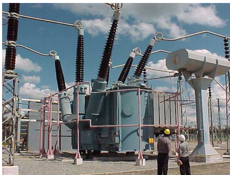
Figura 18 – Transformador instalado na subestação de Campinas, 400 MVA, 345/138 kV (FCE)
