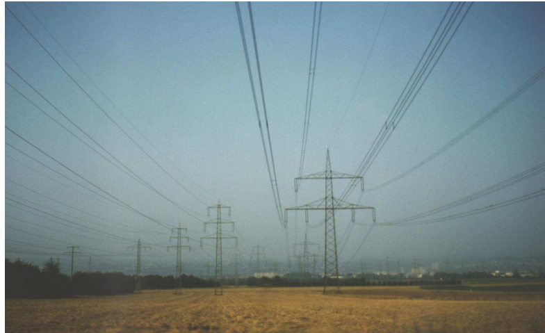
Figura 19 – Corredor de linhas de transmissão na Grande São Paulo (CTEEP)
