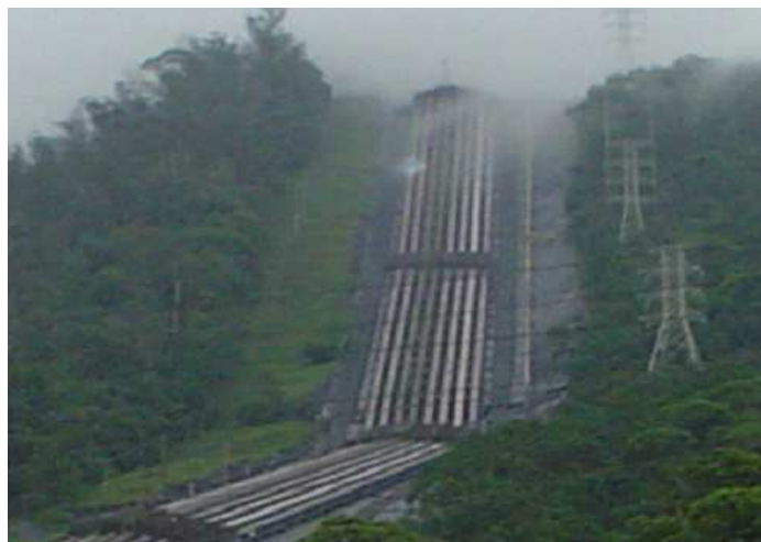
Figura 12 – Tubulação de água (684 metros de queda) Henry Borden - Santos (Eletropaulo)
