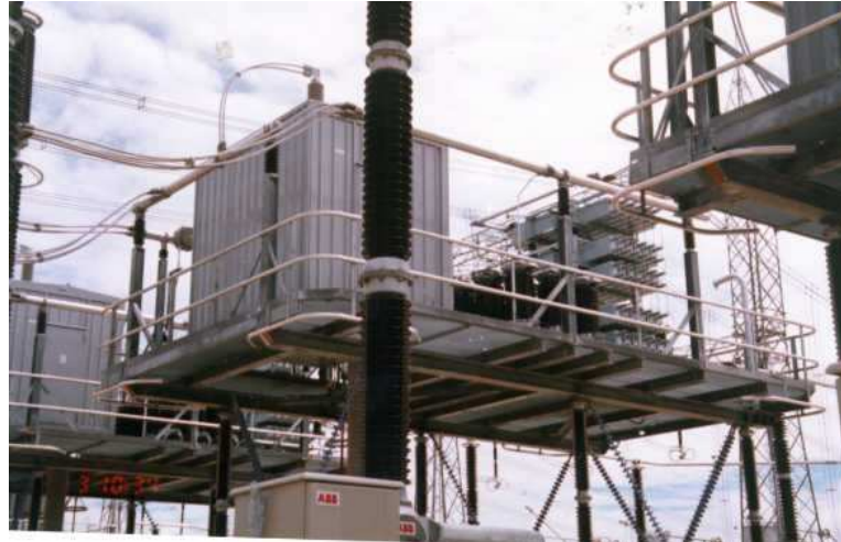
Figura 28 – TCSC de Imperatriz 525 kV, 108 MVar (Eletronorte)
