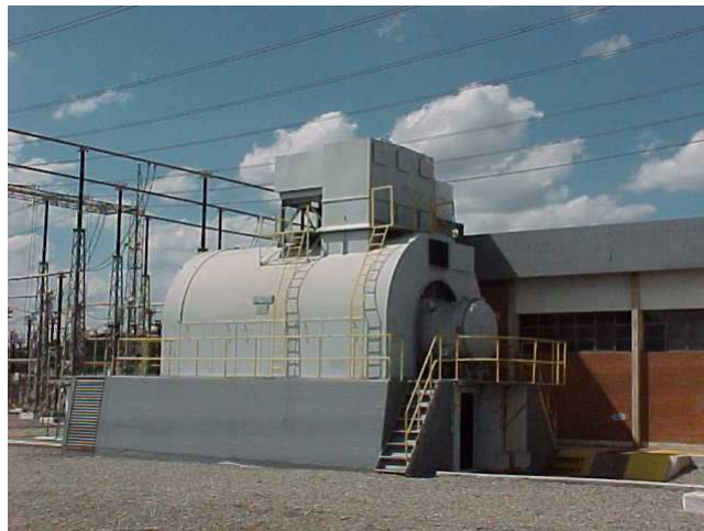
Figura 22 – Compensador síncrono na SE de Neves, +100 MVar/-60 MVar (Cemig)
