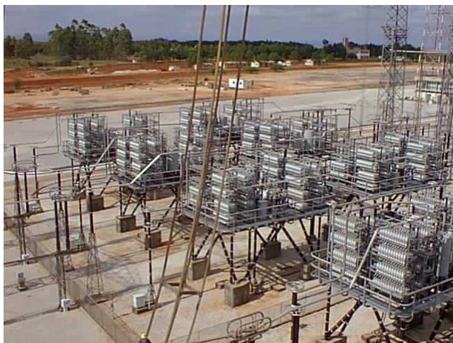
Figura 26 – Banco de capacitores série de Itaberá 750 kV, 1242 MVar (Furnas)
