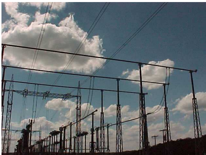
Figura 09 – Barramentos da subestação de Campinas 500/345/138 kV (FCE)
