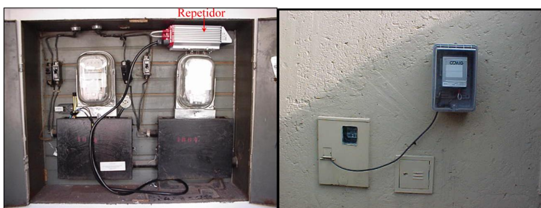
FIGURA 22 – Fotografia do Master PLC e ponto de injeção do sinal
