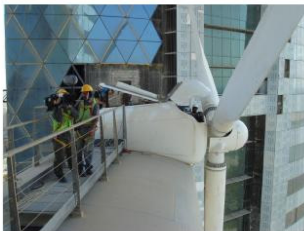
Figura 08 - Instalação de uma das turbinas do BWTC [23].
