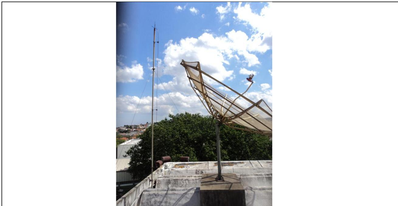
Figura 24. Haste de Franklin protegendo a antena.
