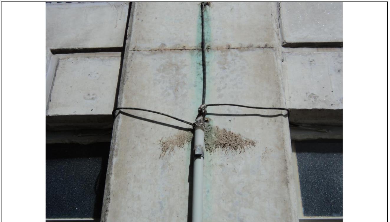
Figura 31. Conexão do cabo de descida na estrutura metálica das janelas
