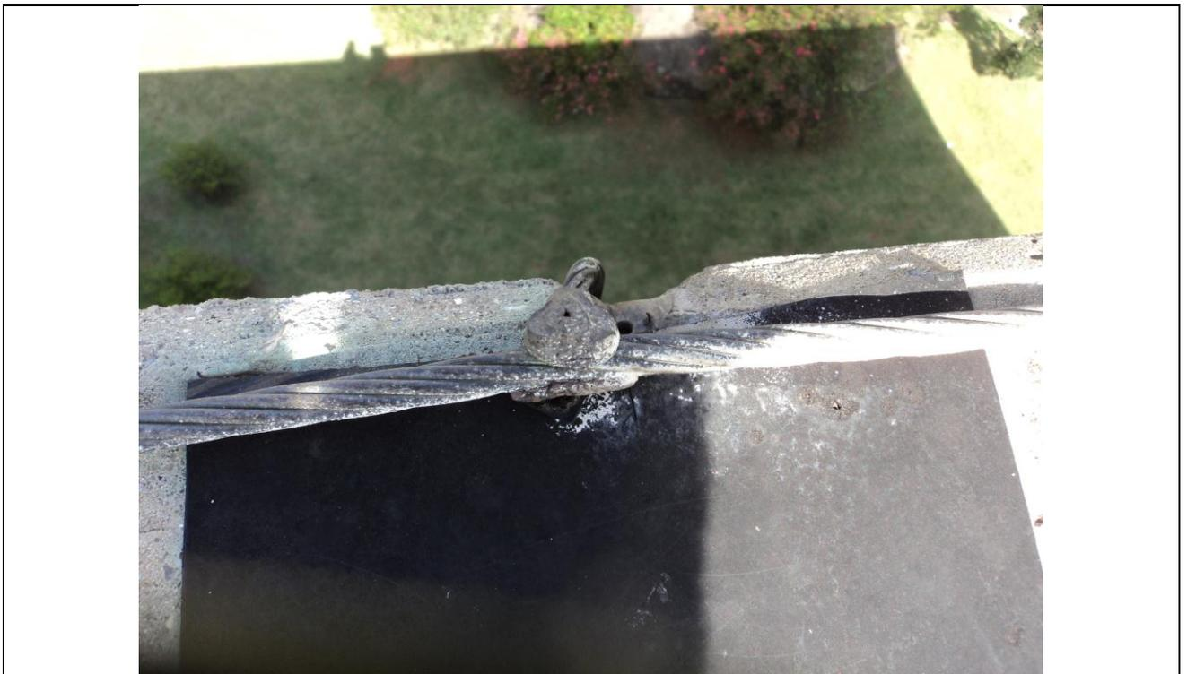
Figura 29. Conexão do cabo de descida
