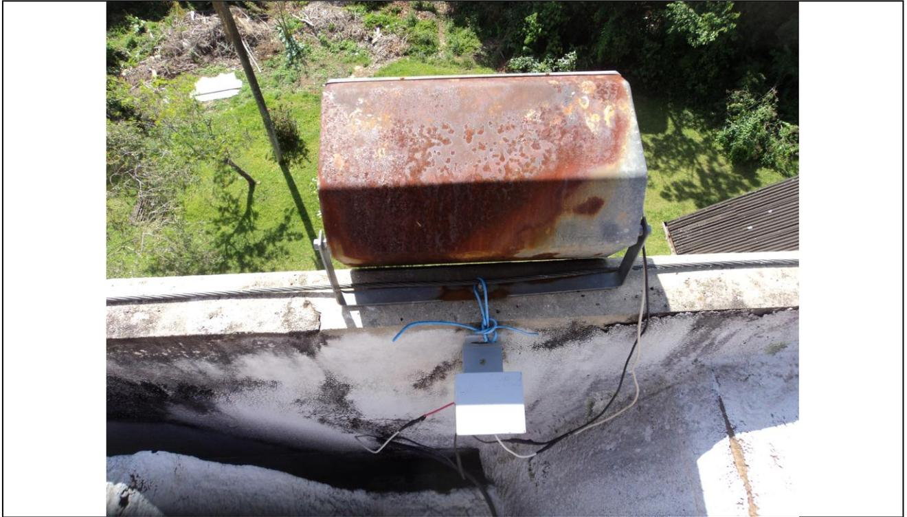
Figura 32. Refletor não conectado ao sistema de para raio
