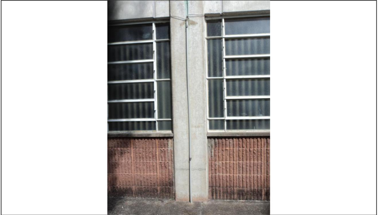
Figura 28. Cabo de descida com tubo protetor
