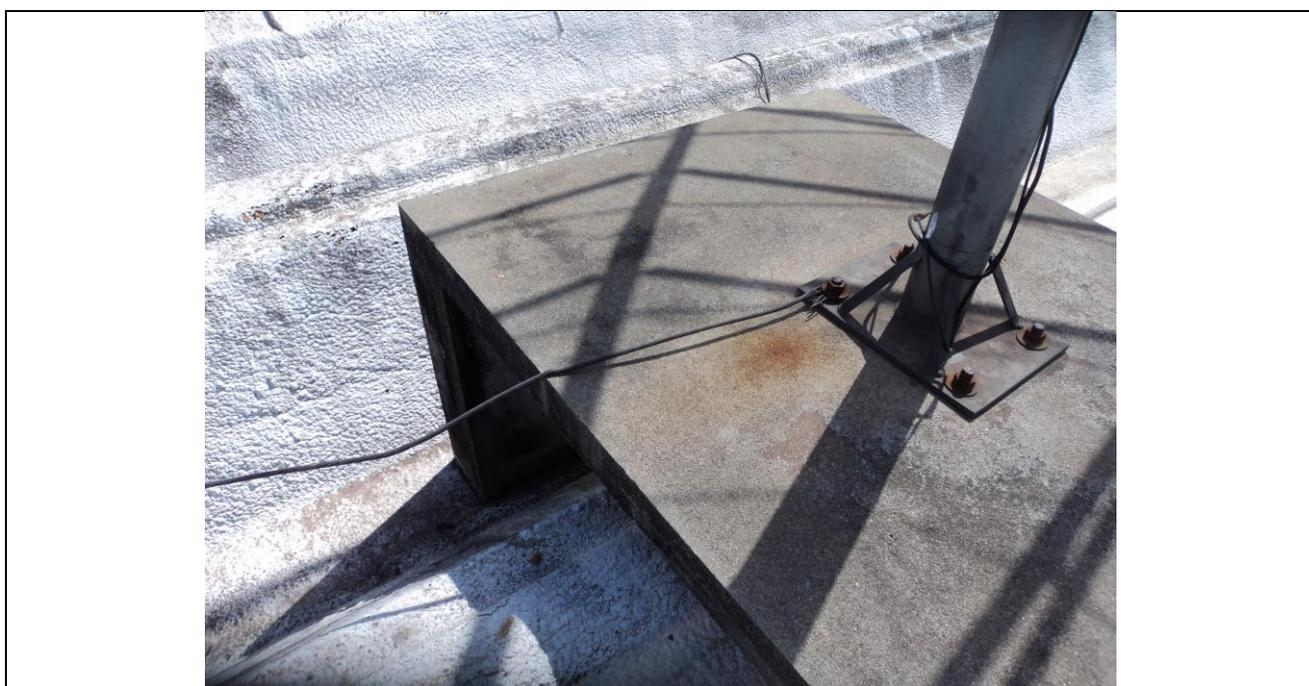
Figura 25. Conexão por pressão mal executada
