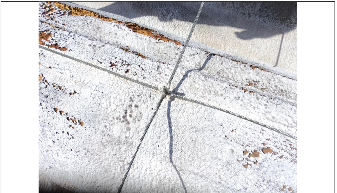
Figura 27. Cruzamento dos condutores da malha da Gaiola de Faraday
