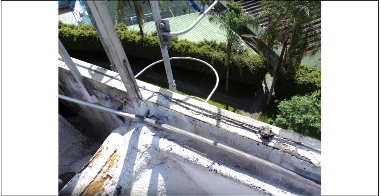
Figura 26. Conexão da escada de acesso
