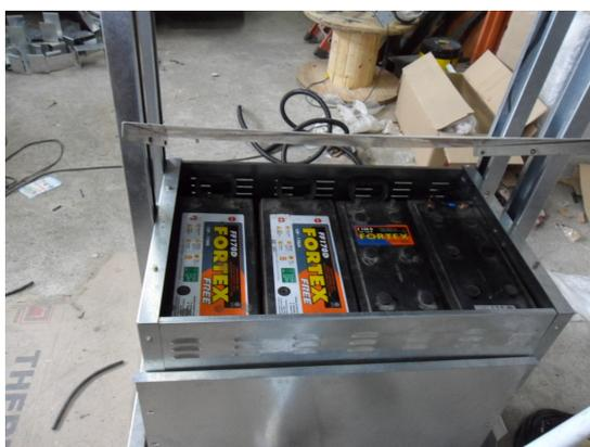
Figura 36 – Caixa de acomodação das Baterias ligadas em paralelo: Fonte GUASCOR
