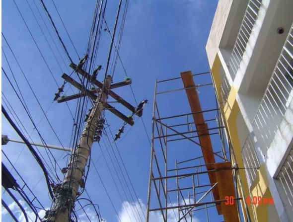
Figura 5: rede aérea oferecendo risco de acidente.
