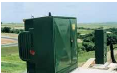
Figura 12: Transformador Tipo Pedestal.
