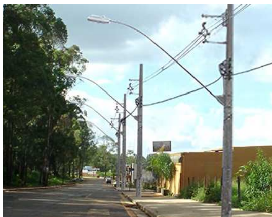
Figura 3: Rede Aérea de Distribuição Compacta.
