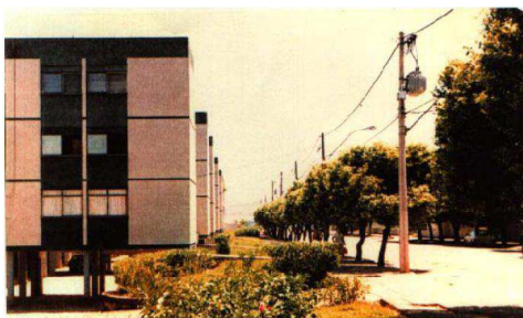
Figura 4: Rede Aérea de Distribuição Isolada.
