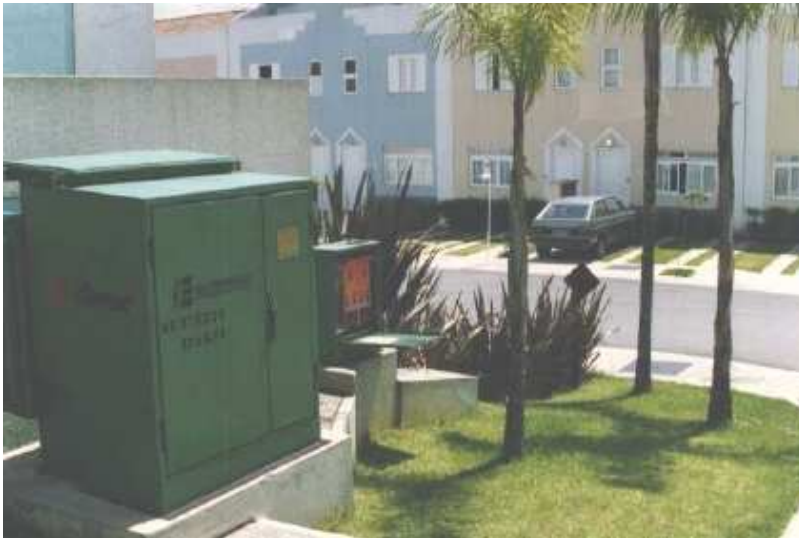
Figura 8 – Transformador tipo Pedestal.
