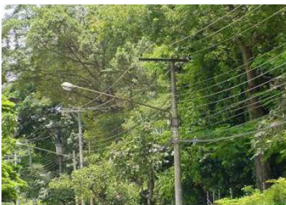
Figura 2: Linha de Distribuição Aérea Convencional.
