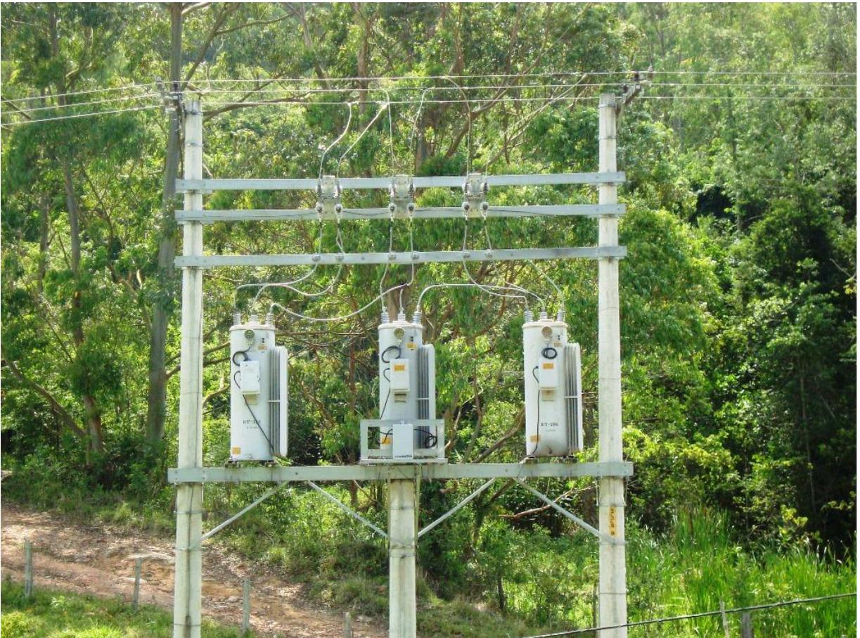
Figura 5 – Banca de regulador de tensão (RT)
