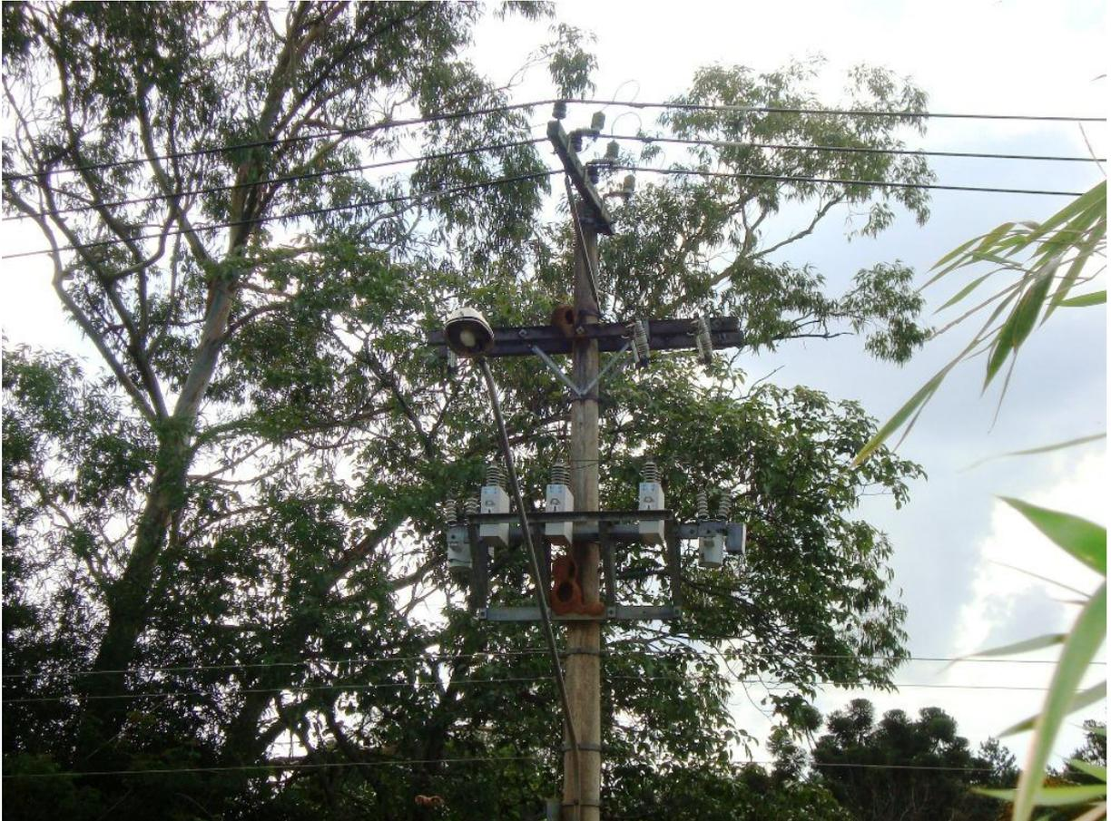
Figura 8 – Banca de capacitor em paralelo
