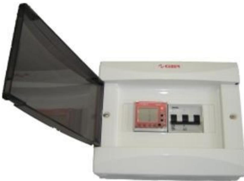
Figura 19 - Medidor montado no painel.
