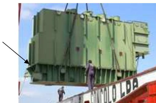
Figura 26. Locomoção do Transformador através de guindaste
