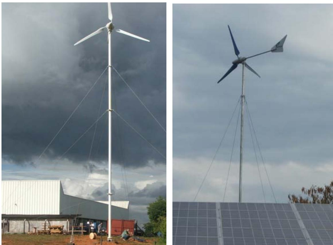
Figura 33. Modelos de aerogeradores de 6000W e de 1000W de potência.
