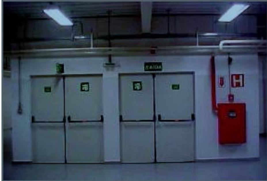
Figura 1: Porta corta fogo com barra anti pânico.
