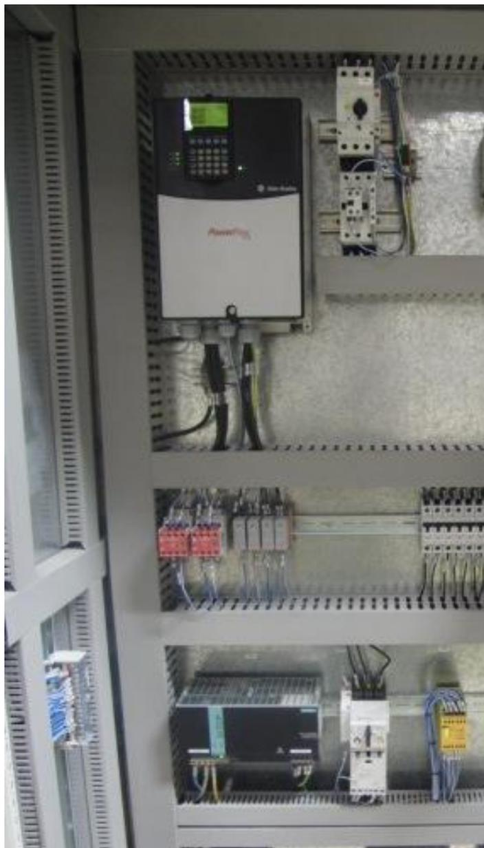
FIGURA 27 – Instalação definitiva do inversor PF70
