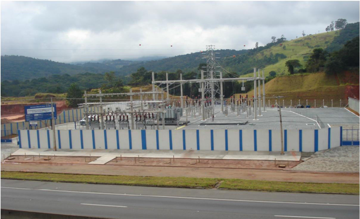
Figura 01 – Subestação Abaixadora
