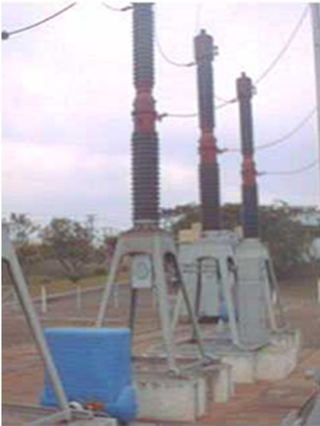
Figura 06 – Disjuntor a Óleo Mineral
