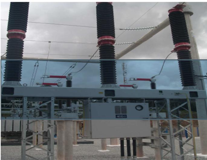
Figura 05 – Disjuntor de Alta Tensão – 138kV
