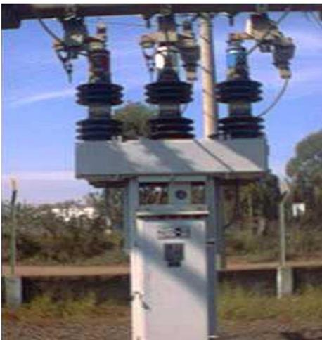
Figura 07 – Disjuntor com meio de extinção do arco elétrica por SF<sub>6</sub>.
