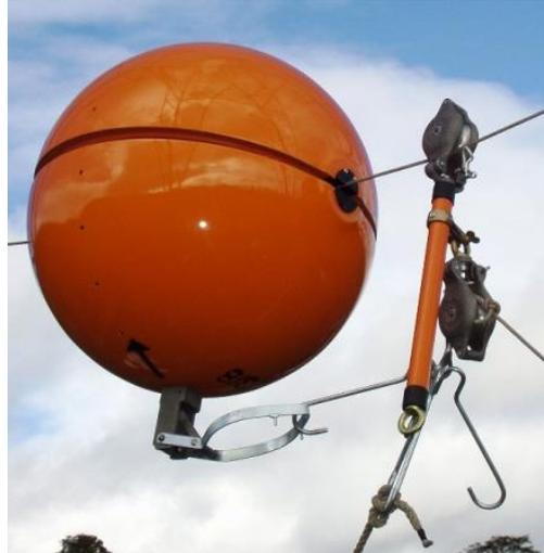
Figura 2 - Esfera em Instalação na Linha de Transmissão (Elektro)
