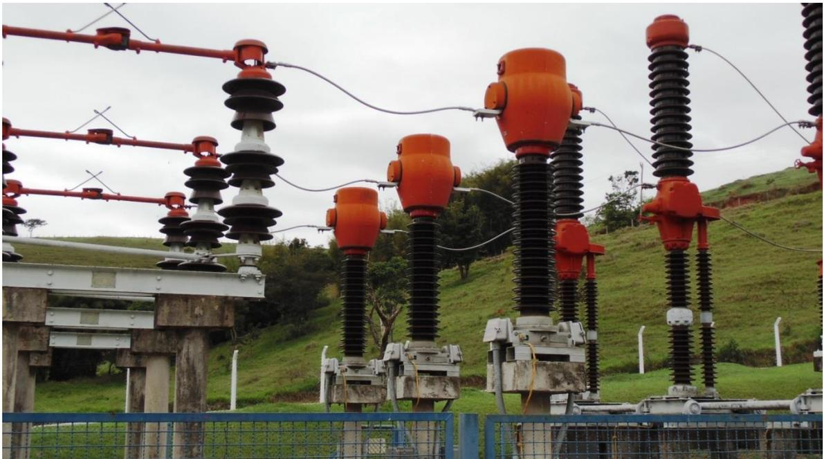
Figura 22 - Transformador de corrente (Subestação Guaratinguetá Elektro)
