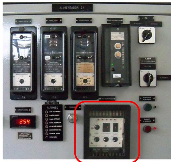
Figura 13 - Painel de proteção com Relé de Religamento Eletromecânico (Subestação Francisco Morato, Elektro)
