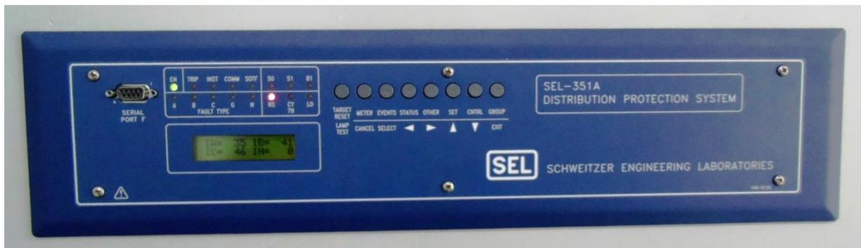
Figura 15: Relé de Religamento Digital SEL 351A Subestação Guaratinguetá (Elektro)
