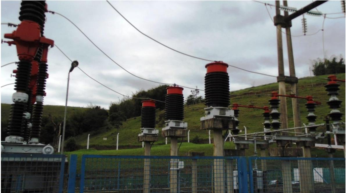
Figura 23 - Transformador de Potencial (Subestação Guaratinguetá Elektro)
