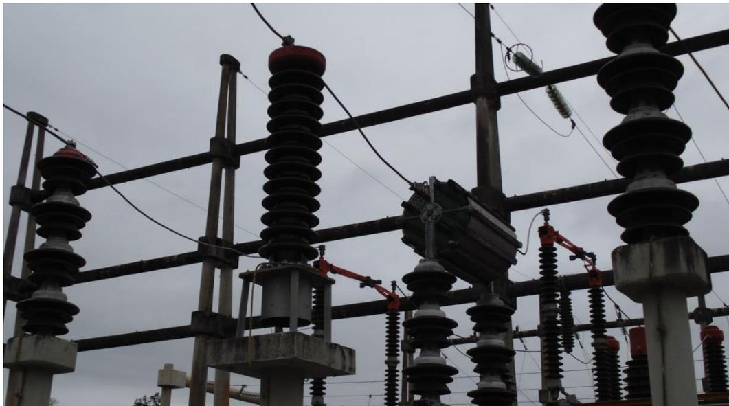
Figura 12 - Sistema Carrier, bobina de bloqueio e TP (Subestação de Cunha, entrada de linha 88kV – Elektro)
