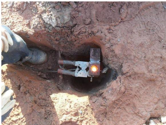
Figura 6 – Confeção de aterramento, Imagem Subestação Atibaia 01, solda Exotérmica (Elektro)
