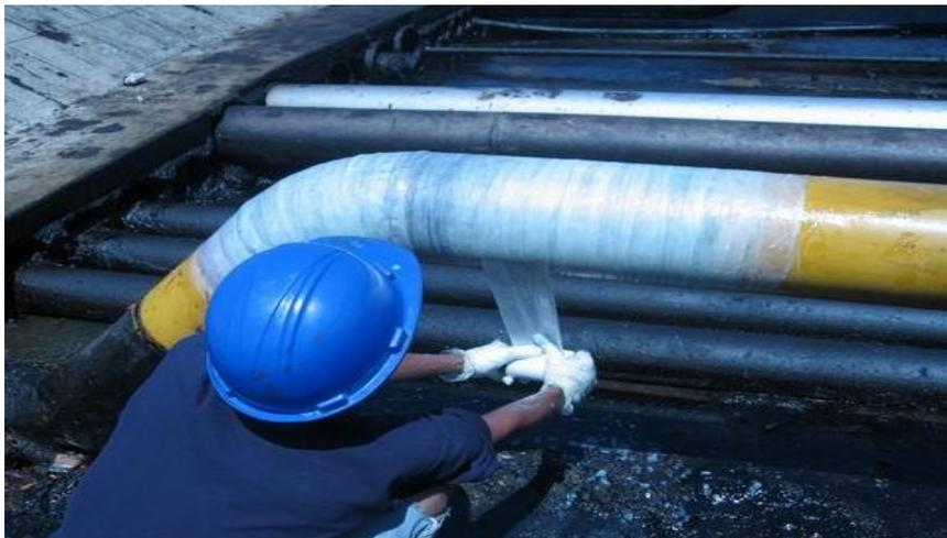
Figura 10. Aplicação da Fita Sealtext
