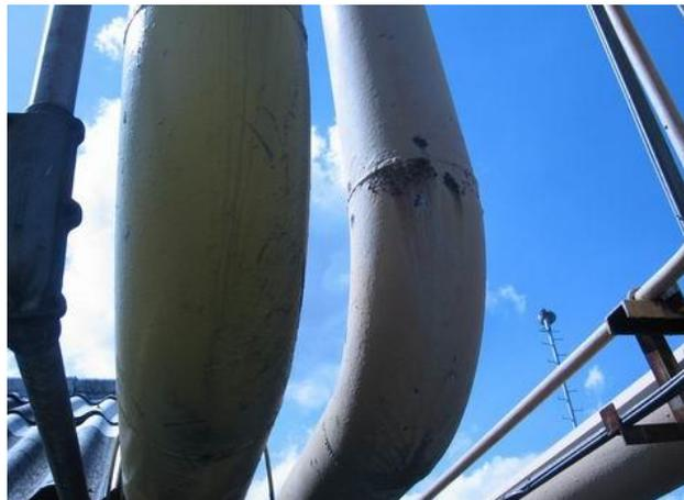
Figura 9. Tubulações apresentando vazamentos
