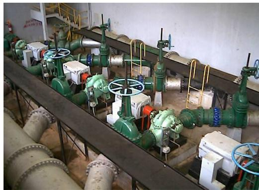
Figura 1. Componentes das bombas estação: motores, válvulas e tubulações.
