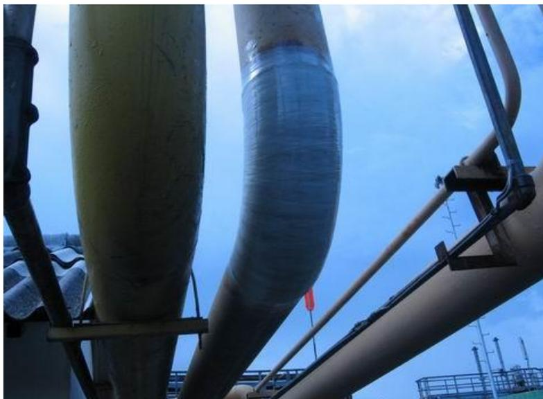
Figura 11. Tubulação após aplicação da Fita Sealtext
