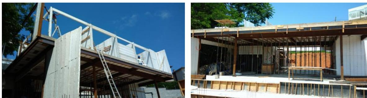
Figura 5: Montagem dos painéis monolíticos.
