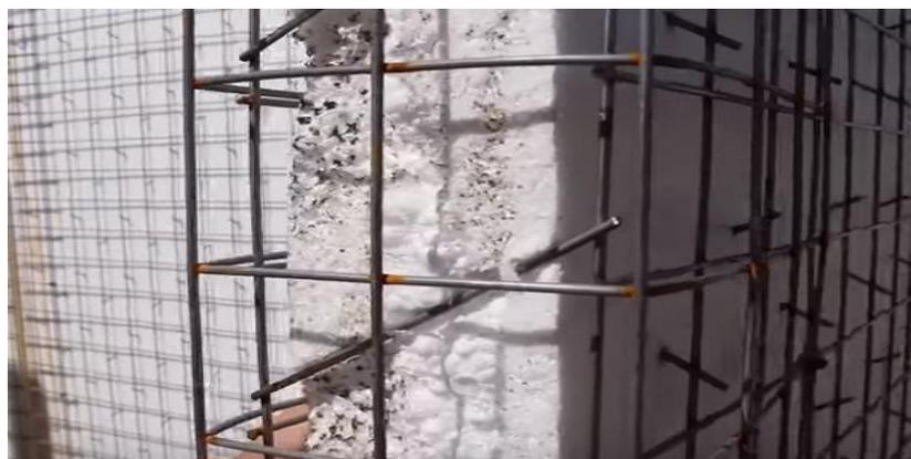
Figura 13: Painel com conectores formando estrutura treliçadas.
