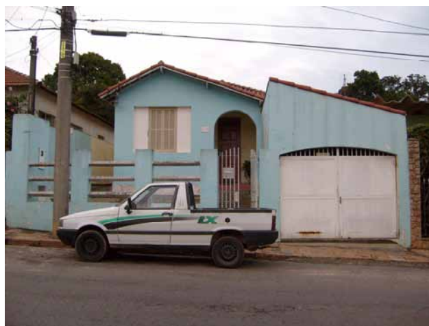
Fig.33. Residência da Vila Belém. Fonte: Acervo particular – 20/06/2009.
