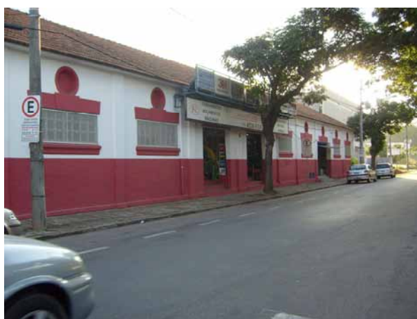
Fig.15. Antigo prédio da Têxtil Paulo Abreu. Fonte: Acervo Particular.
