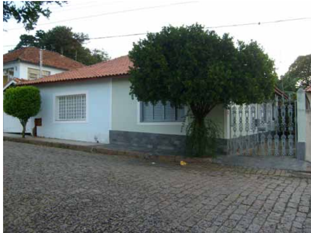
Fig.27. Vista de uma das residências da Rua Santa Rosa. Fonte: Acervo particular – 01/04/2009.
