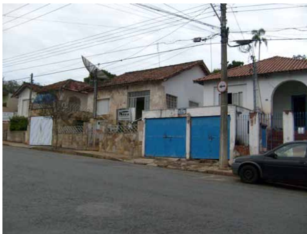
Fig.33. Residência da Vila Belém. Fonte: Acervo particular – 20/06/2009.
