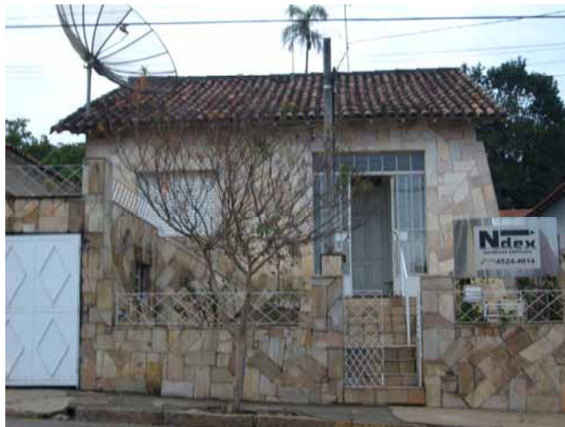
Fig.32. Residência da Vila Belém. Fonte: Acervo particular – 20/06/2009.
