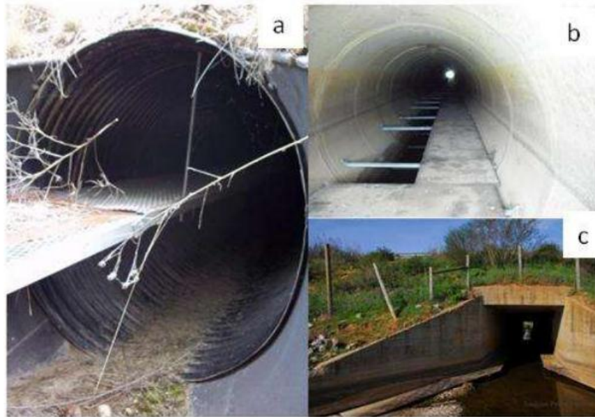
FIGURA 3 Modelos de passagens subterrâneas – galerias, demonstrando as pranchas suspensas(a), as muretas laterais(b) e (c) saída de uma galeria.
