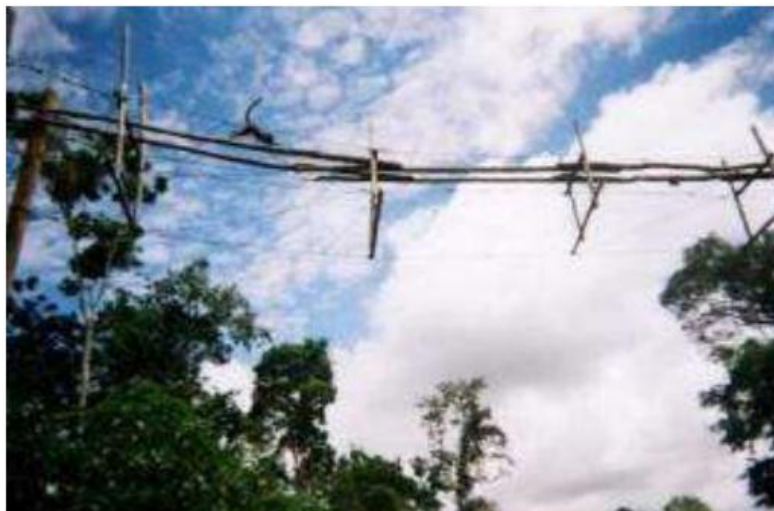
FIGURA 5 – Modelo de Passagens aéreas para vertebrados arborícolas, instalado na cidade de Madagascar.
