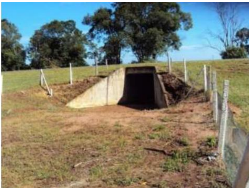
FIGURA 4- Entrada de uma passagem subterrânea tipo caixa seca, instalada na cidade de Brotas no interior de São Paulo.
