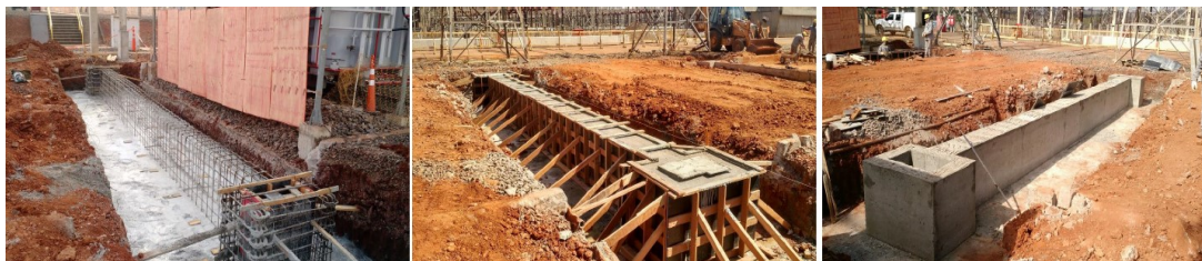
Figura 12 – Concretagem da Sapata e da Viga da Sapata – (Fonte: Próprios autores).
