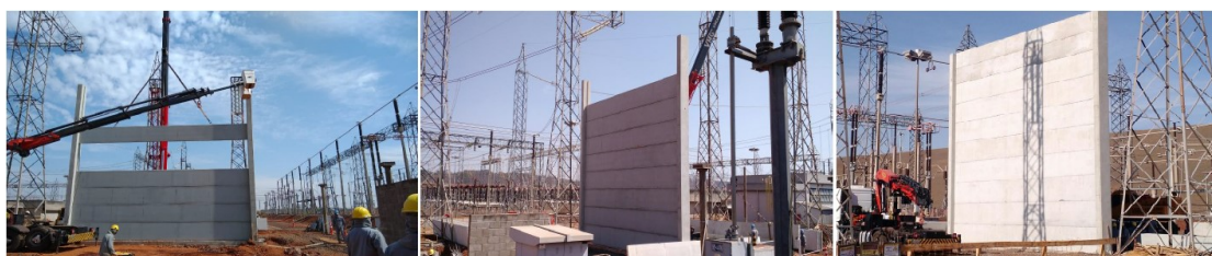
Figura 13 – Montagem da PCF entre fase 1 e fase 2 – (Fonte: Próprios autores).
