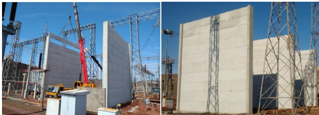
Figura 15 - Montagem da PCF na fase 3 – (Fonte: Próprios autores).
