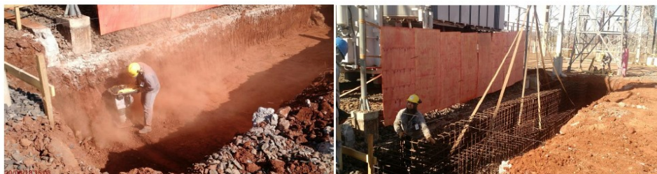
Figura 11 – Montagem e Instalação de Armaduras – (Fonte: Próprios autores).
