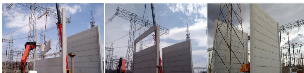
Figura 14 – Montagem da PCF entre fase 2 e fase 3 – (Fonte: Próprios autores).
