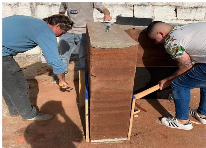
**Figura 11** – Processo de desforma
