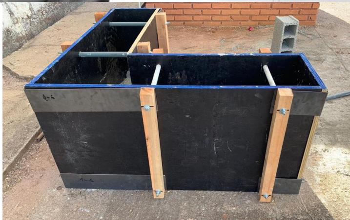
**Figura 8** – Montagem da fôrma concluída
