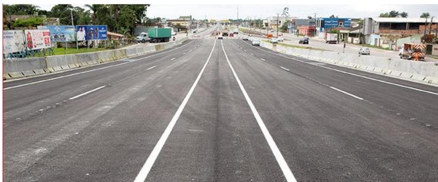
**Figura 11** - Rodovia com asfalto-borracha (Fonte: AECWEB)<sup>10</sup>.
