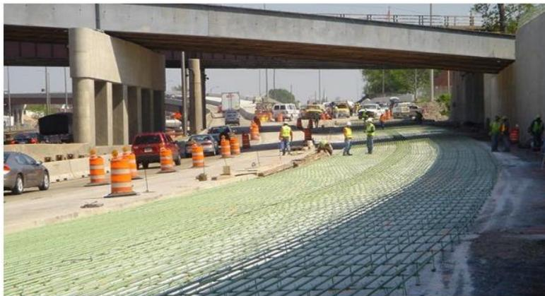
**Figura 9** - Pavimento de concreto reforçado com aço. (Fonte: FLAT OUT)<sup>9</sup>.
