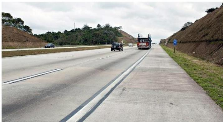
**Figura 7** - Pavimentação rígida, feita de concreto de cimento. (Fonte: FLAT OUT)<sup>8</sup>.
