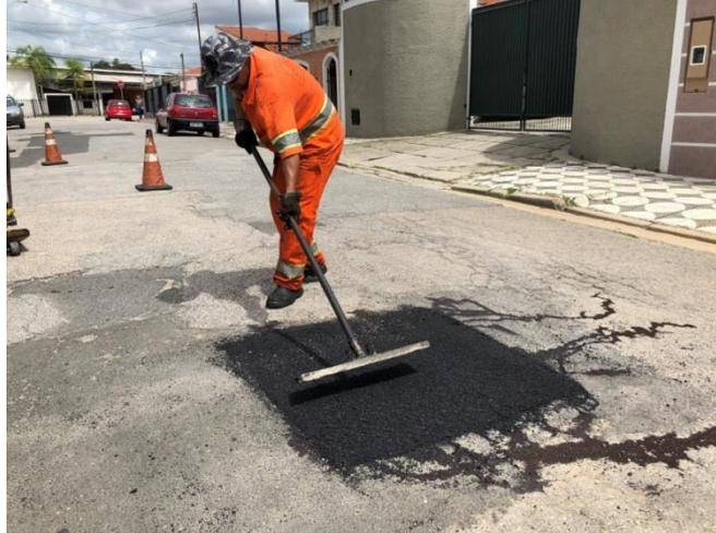
**Figura 4** - Operação tapa-buracos sendo realizada em via danificada. (Fonte: Site da PREFEITURA DE SOROCABA)<sup>5</sup>.
