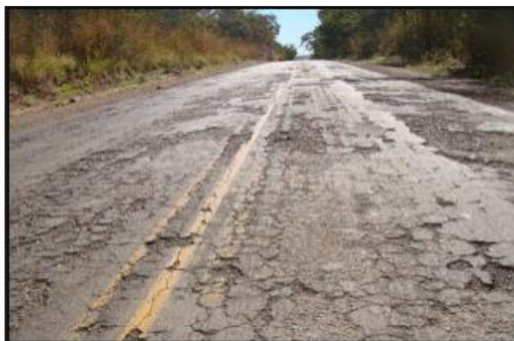
**Figura 3** - Pavimento deteriorado. (Fonte: ASFALTO DE QUALIDADE. Cuidados na pavimentação)<sup>2</sup>.
